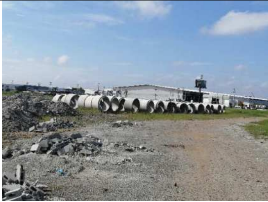
Tubos de concreto para ser colocados como parte del drenaje pluvial.
