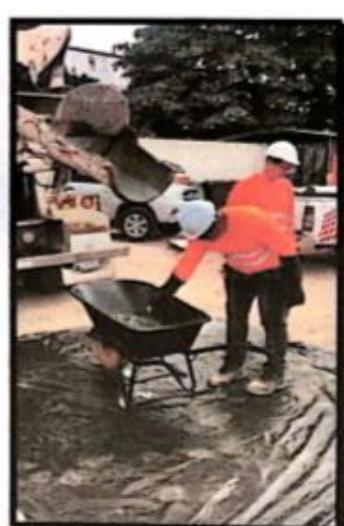
Figura. 7 Se estableció área para prueba de asentamiento para vaciado de concreto
