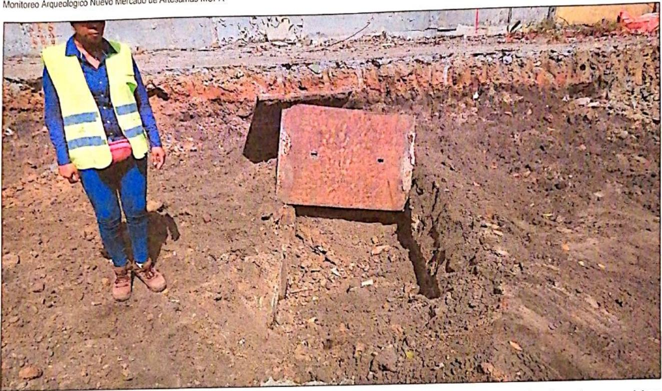
Figura 6) Conducto de concreto encontrado hacia el norte del predio, tapado por planchas de acero y que corre en dirección norte-sur, paralelo a las líneas férreas originales.
