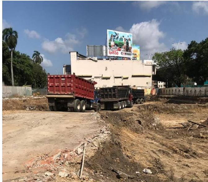
**Fotografía No.1:** El material removido de la preparación del terreno es transportado hacia el relleno sanitario.
