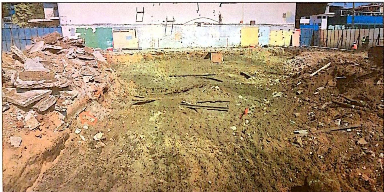
Figura 5) Remoción de tierra en el sector norte del predio. A la izquierda se observan posibles restos del andén para pasajeros del ferrocarril señalados por la flecha roja, mientras que al centro están apilados restos de rieles de ferrocarril.
