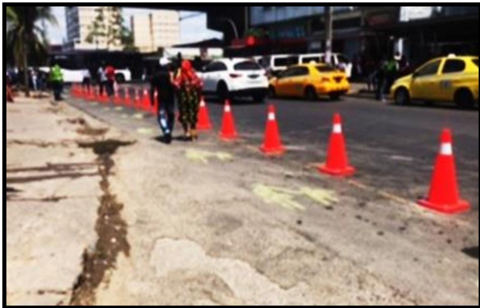
Figura 7. Se mantiene el área del peatón señalizada y adecuada con conos de seguridad a 10 metros cubriendo el área de circulación hasta el semáforo y paso de peatón.
