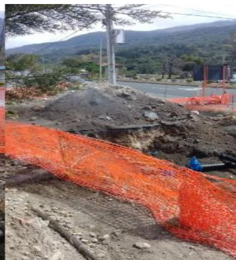
Fotografía 8. Uso de mallas de seguridad en excavaciones
