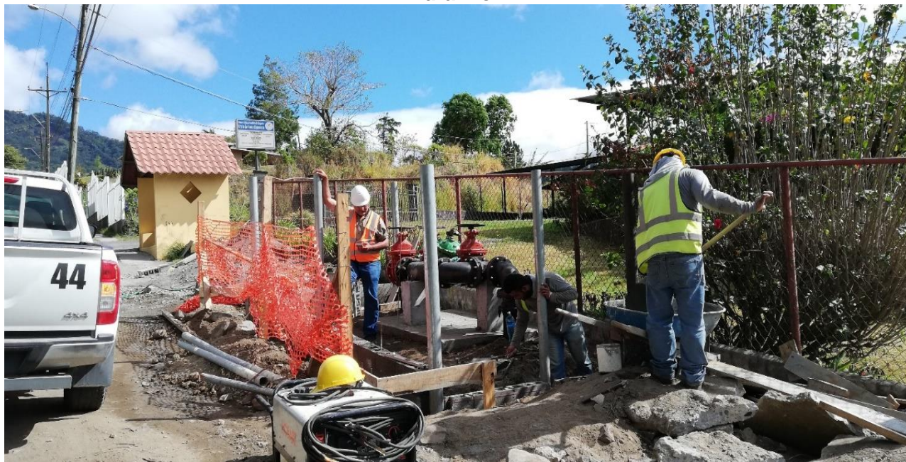
Fotografía 15. Construcción de pedestales para válvulas reguladoras en horario diurno
