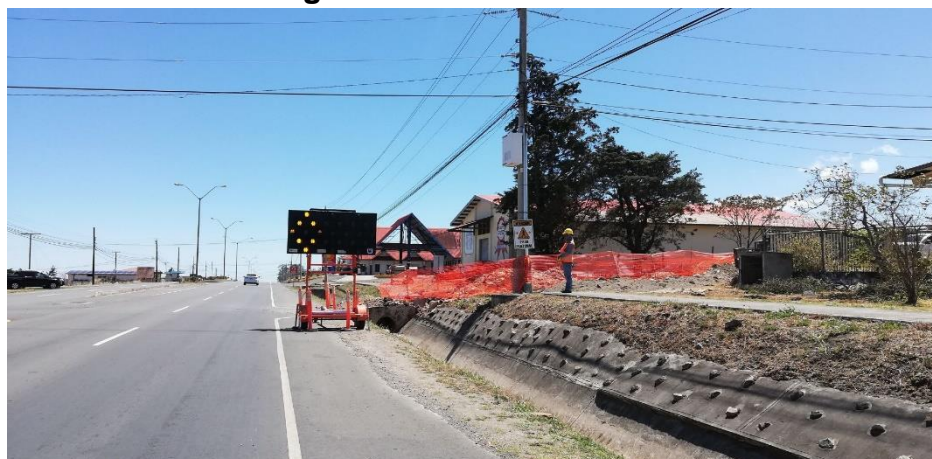
Fotografía 8. Uso de mallas de seguridad en excavaciones
