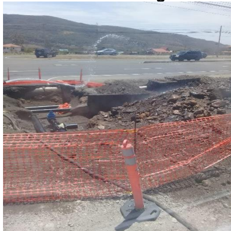
Fotografía 8. Uso de mallas de seguridad en excavaciones
