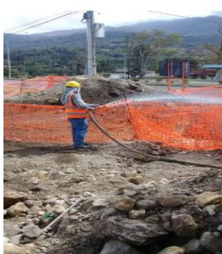
Fotografía 8. Uso de mallas de seguridad en excavaciones
