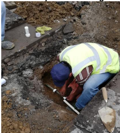
Fotografía 27. Cubrimiento de material edáfico generado en las excavaciones
