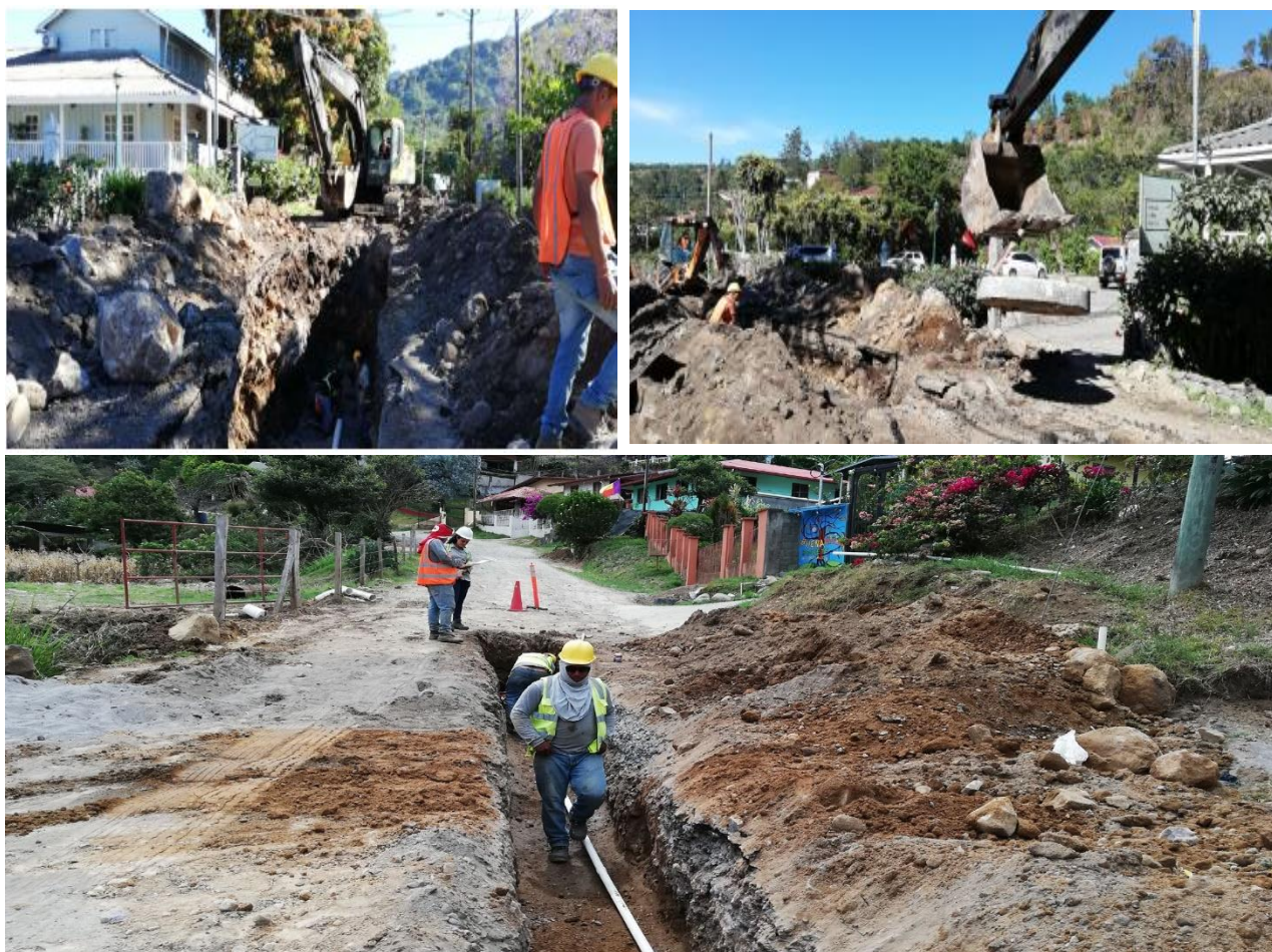
Fotografía 12 Excavaciones para colocación de tuberías y cámaras de inspección del sistema sanitario en la Ave 11 de Abril
