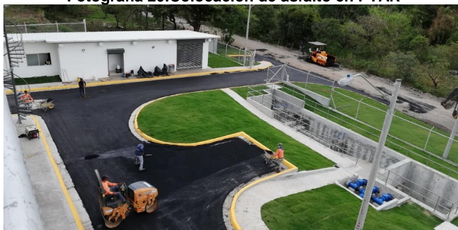
Fotografía 20. Colocación de asfalto en PTAR
