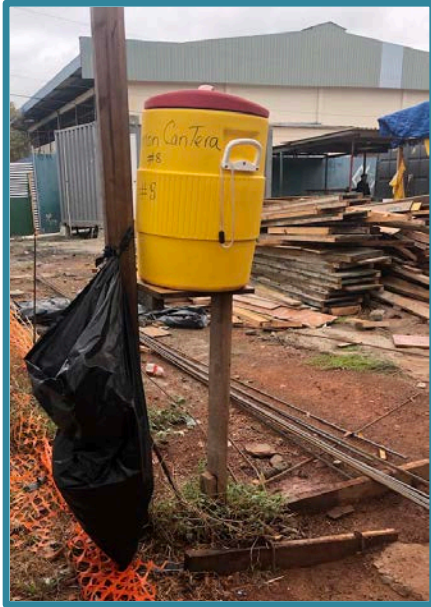
Provisión de agua potable para los trabajadores por frente de trabajo, con bolsa para disposición de desechables
