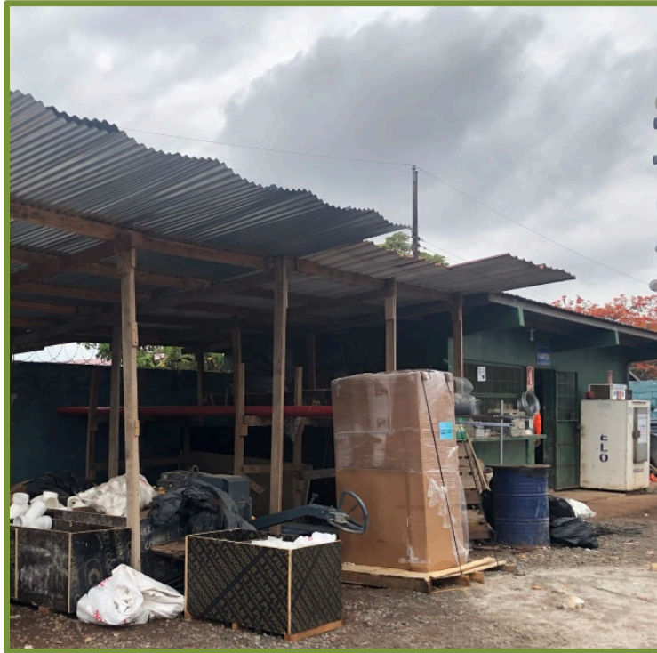
Almacenamiento temporal de insumos para el proyecto, sobre pallets y recubiertos, dispositivos para el acopio temporal de desechos sólidos con tapa
