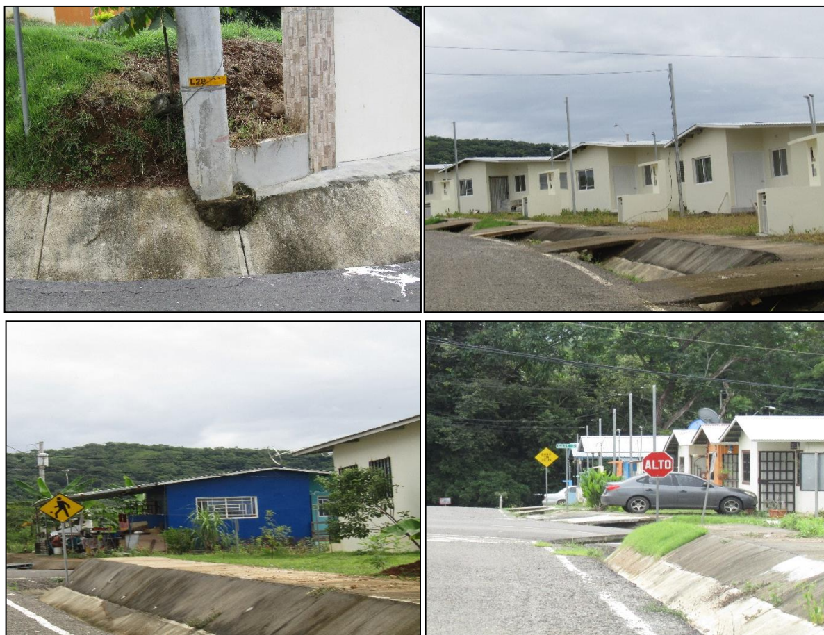
Fotografía N°35-38. Sistema de drenaje pluvial (cunetas).
