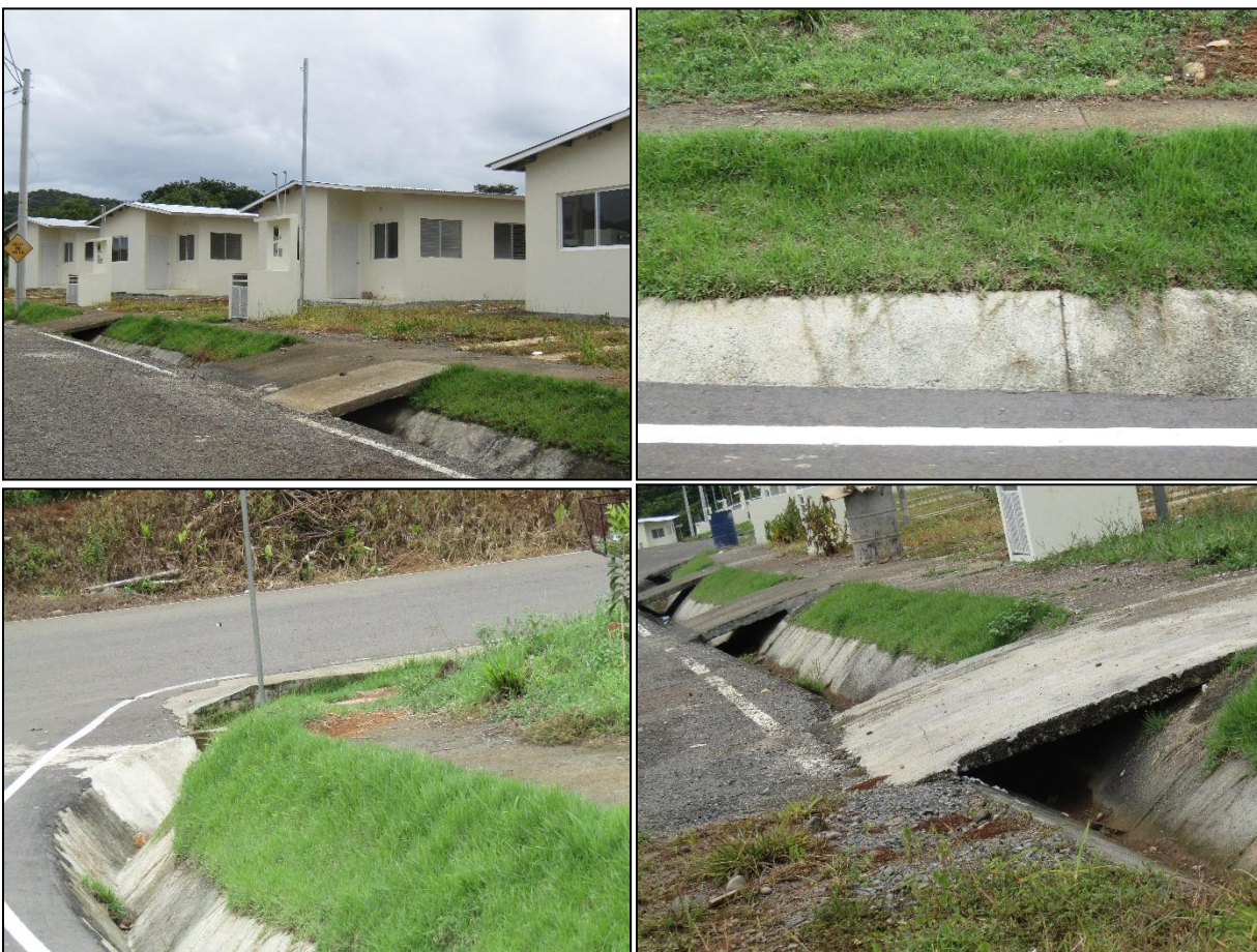
Fotografía N°:17-20 Cunetas revestidas de concreto y de grama
