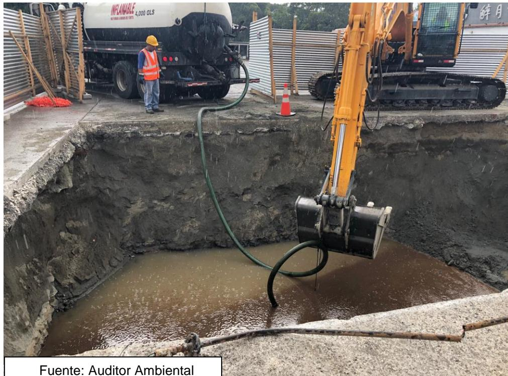
Foto No. 4 Saneamiento del área de intervención, donde se encontraban los tanques que serian retirados, se tomaron las medidas de retiro de residuos líquidos para evitar acumulación de desechos que dificulten la ejecución de las labores.
