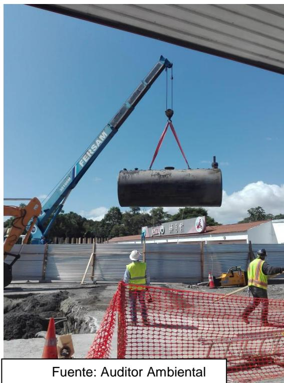
Foto No.3 Izaje de tanques: los mismos se realizaron con todas las medidas de seguridad previamente establecidas en el Plan de Manejo Ambiental.
