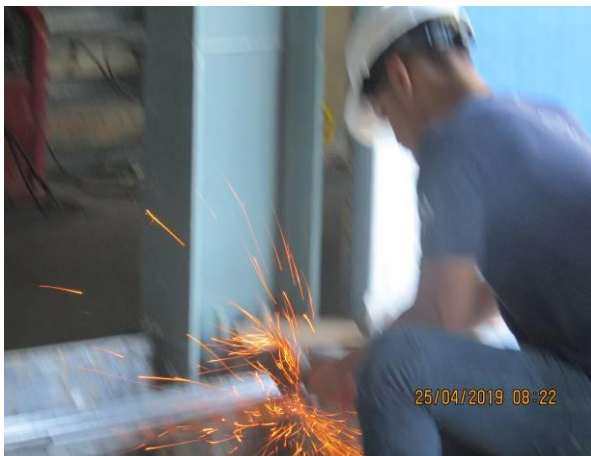
Imágenes 2.1.5 y 2.1.6. Fuente generadora de partículas: corte de acero con flexible
