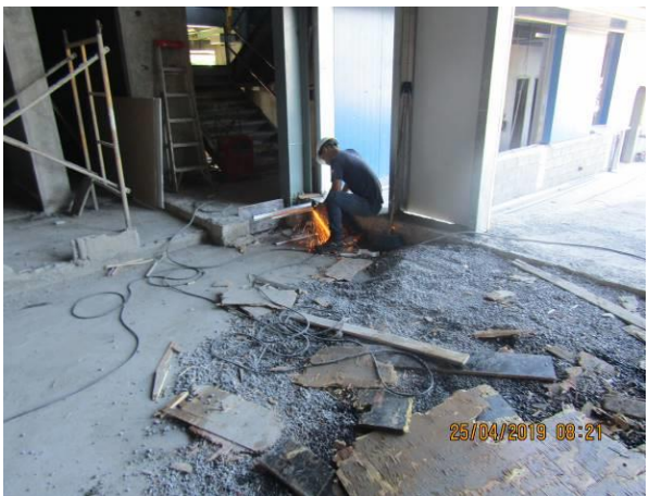
Imágenes 2.1.5 y 2.1.6. Fuente generadora de partículas: corte de acero con flexible
