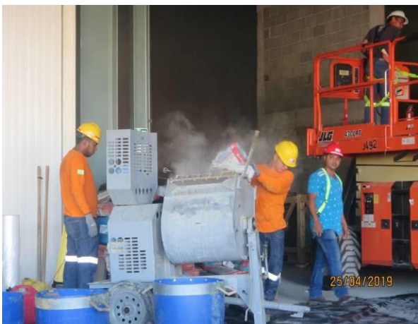
Imágenes 2.1.3 y 2.1.4. Fuente generadora de partículas: mezcladora de concreto
