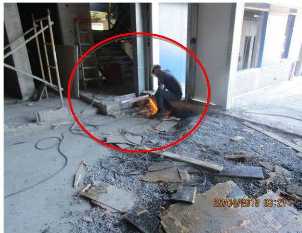
Imágenes 2.4.3 a 2.4.5. Fuentes de ruido identificadas (alarma de retroceso del elevador hidráulico, mezcladora de cemento y flexible)
