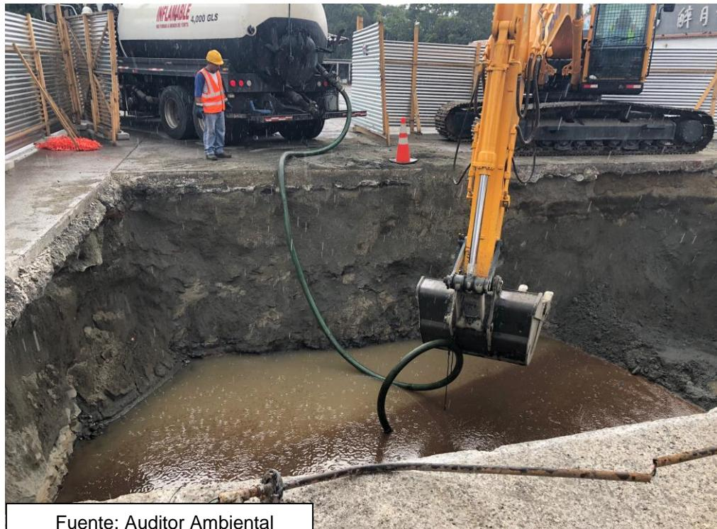
Foto No. 4 Saneamiento del área de intervención, donde se encontraban los tanques que serían retirados, se tomaron las medidas de retiro de residuos líquidos para evitar acumulación de desechos que dificulten la ejecución de las labores.
