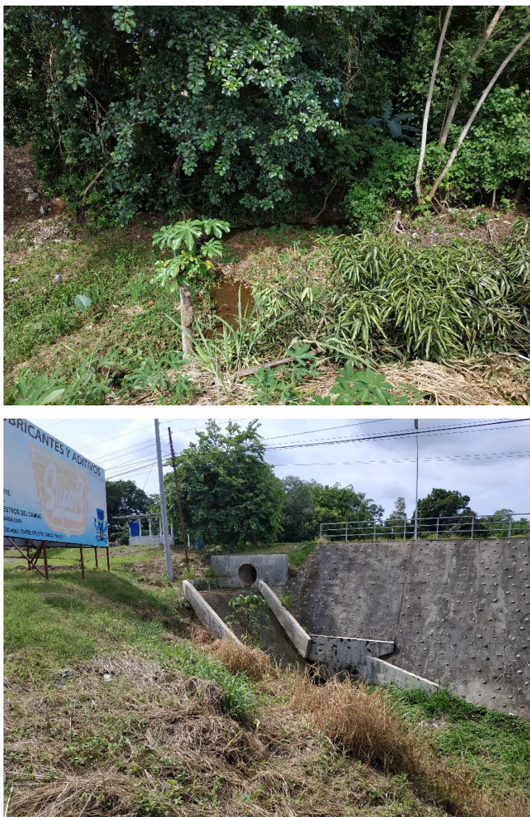
Figura 10-11. Arriba; Quebrada Llano del Bichal. Abajo; Estructura de desalojo de agua de escorrentía
