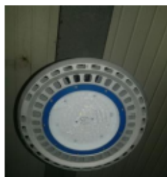
Lámparas LED de 100Watt instaladas
