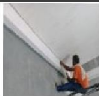
Colocando Sika 221 a las aberturas de los paneles del cuarto de tránsito
