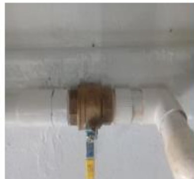
Fuga de Agua en salida de 2 pulgada en el Área de Recibo 16 de Abril 2018
