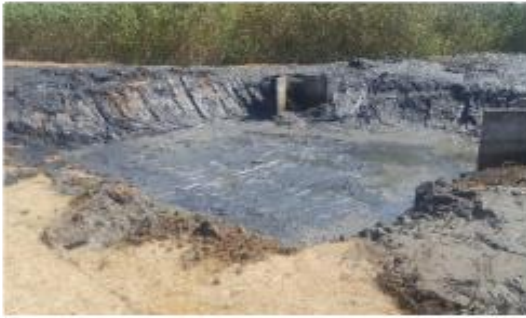
LIMPIEZA DE LAS TINAS DE OXIDACIÓN
