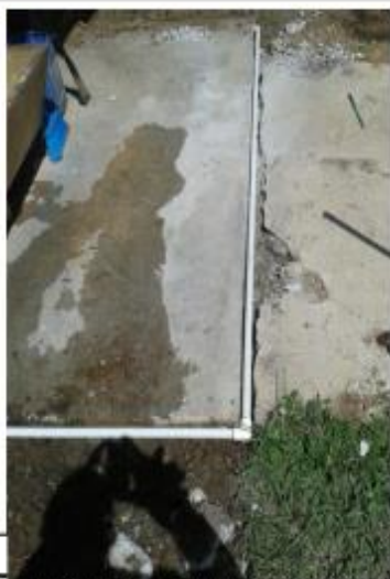
Fuga de Agua en salida de 2 pulgada en el Área de Recibo 16 de Abril 2018
