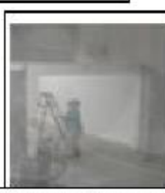
Realizando los recortes de pintura en las áreas donde entra el rodillo.
