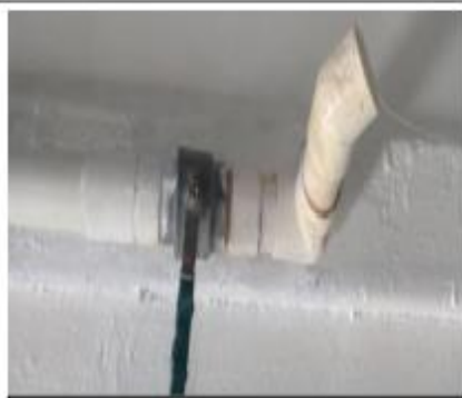
Fuga de Agua en salida de 2 pulgada en el Área de Recibo 16 de Abril 2018
