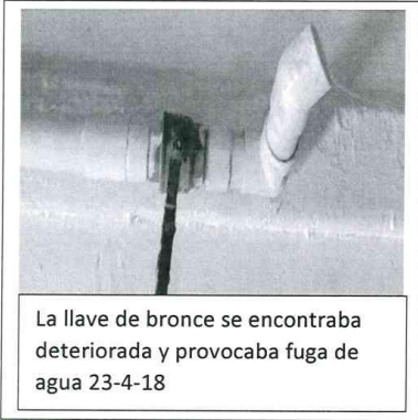
Fuga de Agua en salida de 2 pulgada en el Área de Recibo 16 de Abril 2018
