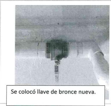
Fuga de Agua en salida de 2 pulgada en el Área de Recibo 16 de Abril 2018
