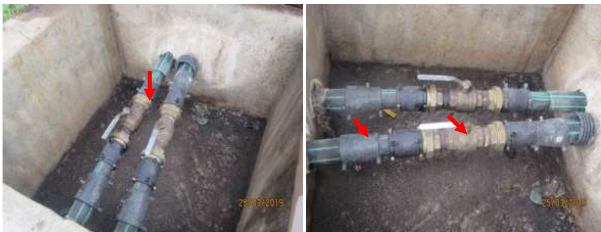
Imágenes 14 y 15. Válvulas en las tuberías de combustible
