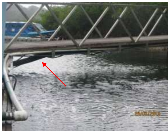
Imágenes 12 y 13. Vistas de los tubos que confinan las tuberías de combustible para evitar derrames al medio marino en caso de colapsar
