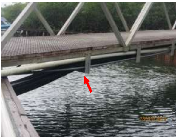
Imágenes 12 y 13. Vistas de los tubos que confinan las tuberías de combustible para evitar derrames al medio marino en caso de colapsar
