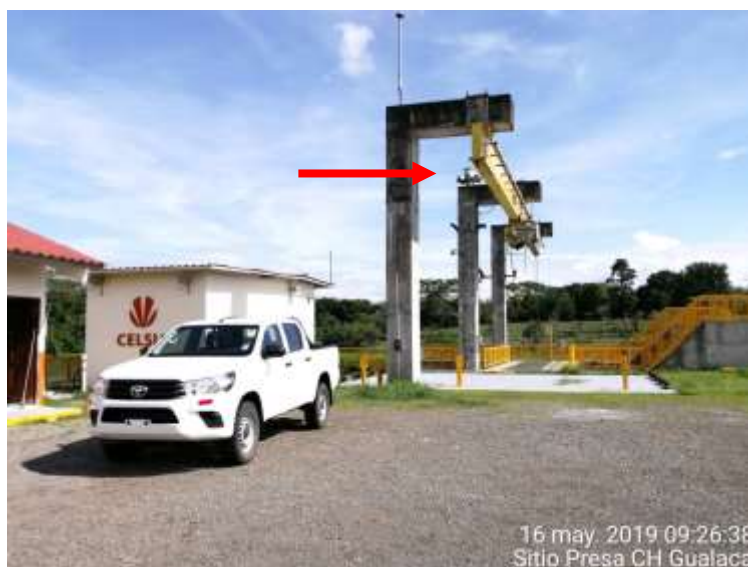
Fotografía No. 31: Sistema de alarmas en caso de emergencias en la CH Gualaca.
