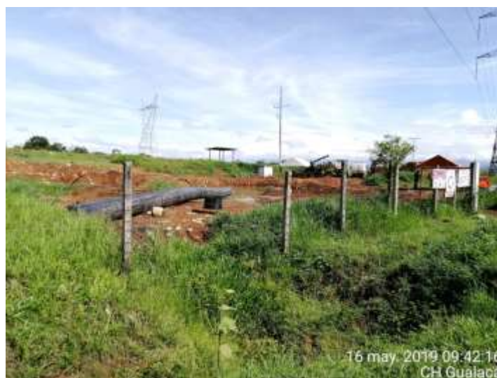
Fotografía No. 15: Trabajos de reparación de sifones.
