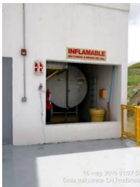
Fotografía No. 6: Almacenamiento de hidrocarburos dentro de sistema de contención, identificación de niveles de peligrosidad del producto y kit para caso de derrames.
