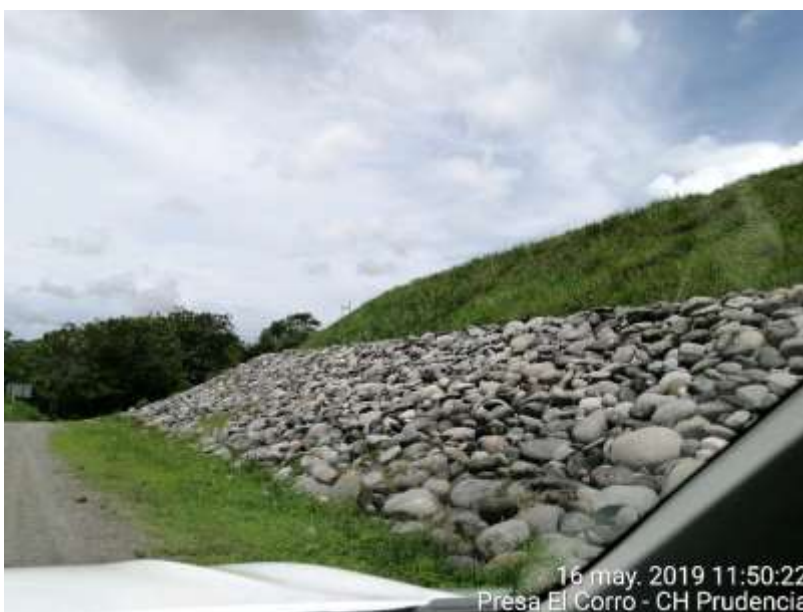
Fotografía No. 2: Estabilización de taludes en CH Prudencia.
