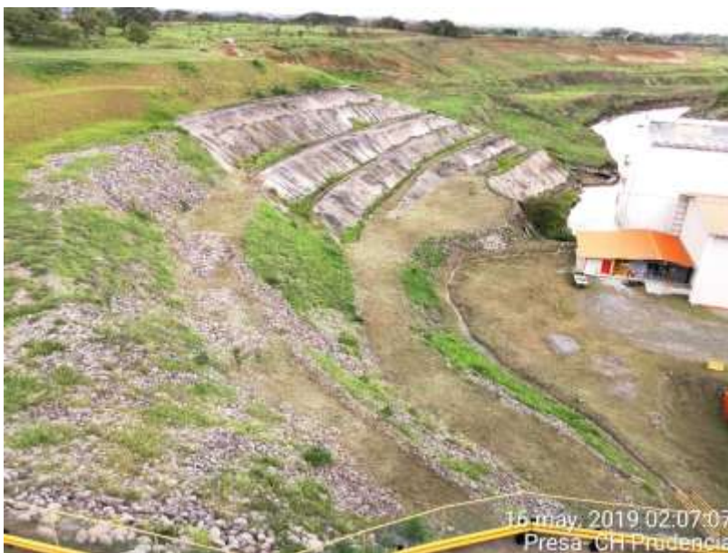
Fotografía No. 3: Trabajos de mantenimiento y estabilización de taludes en CH Prudencia.
