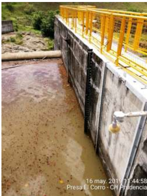
Fotografía No. 24: Reglas limnimétricas en CH Prudencia.
