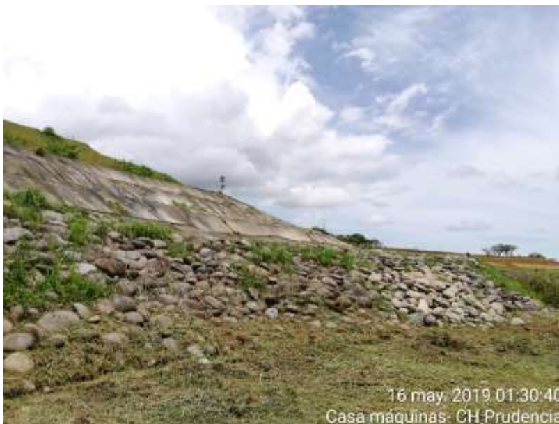
Fotografías No. 4: Revegetación y estabilización de taludes en CH Prudencia.
