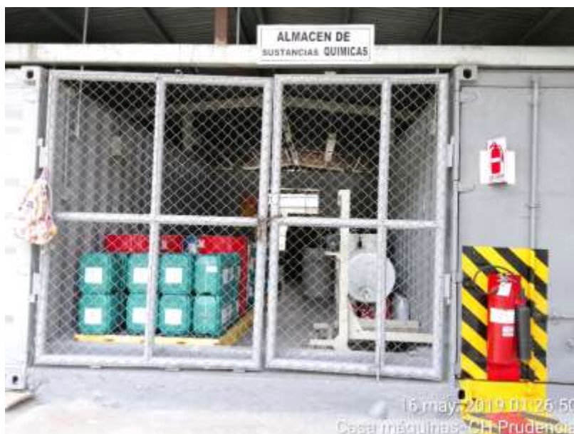
Fotografía No. 5: Almacenamiento de sustancias químicas, dicho almacén se encuentra identificado y mantiene sistema de contención en caso de derrames.
