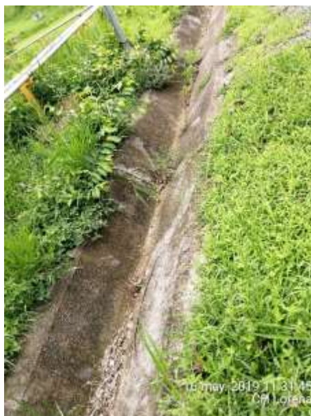
Fotografía No. 3: Sistema de canalización de aguas pluviales.
