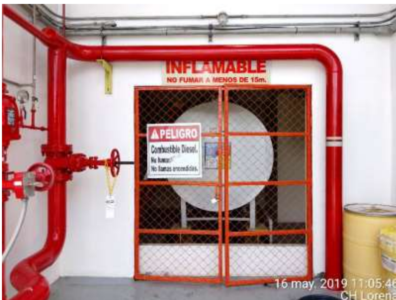
Fotografía No. 7: Señalización de niveles de peligrosidad de productos utilizados y sistema de contención en caso de derrames.
