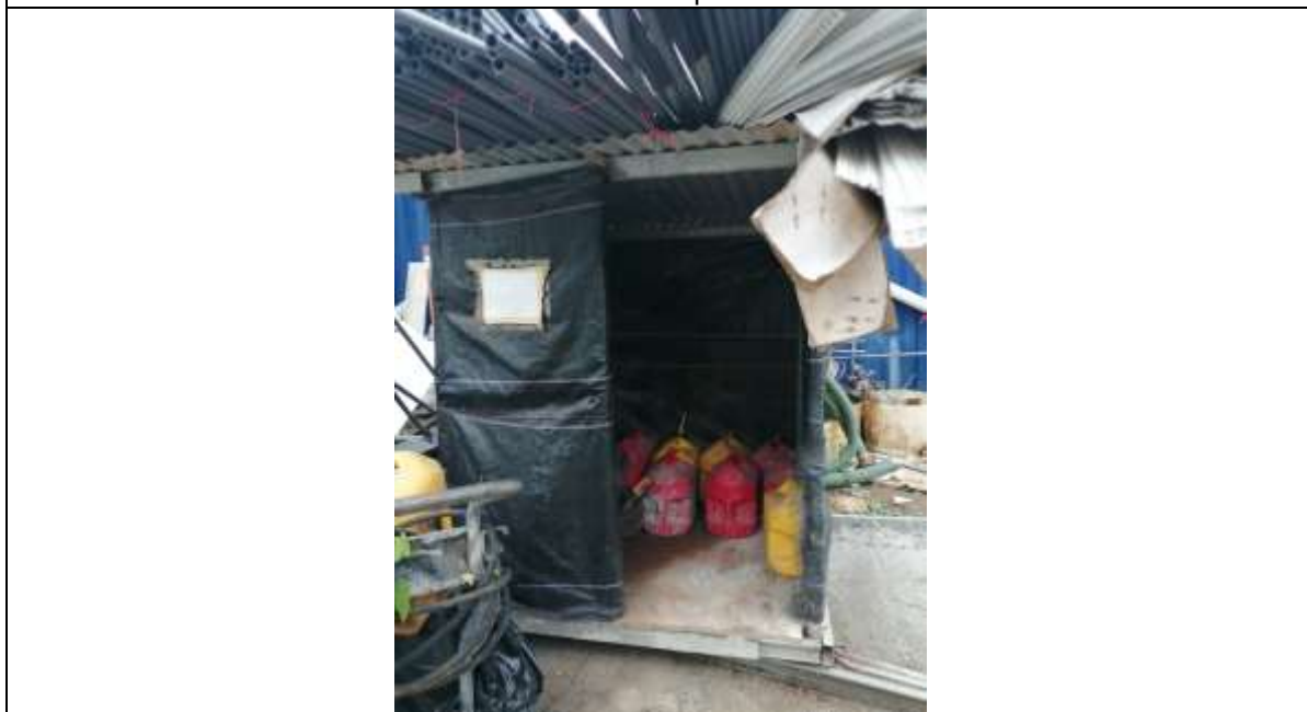
Fotografía No.8: Lugar de almacenamiento de combustible con su noria de contención
