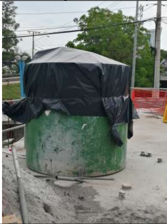
Fotografía No. 12: Se tanque de agua no potable utilizado para actividades de la construcción.
