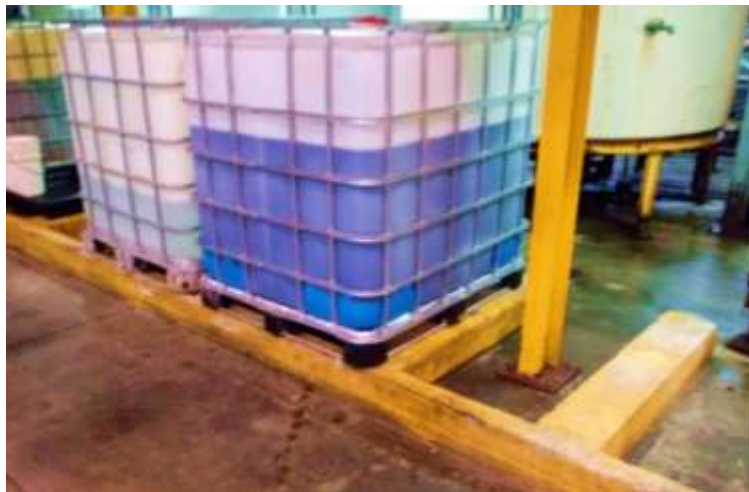
Fotografía No. 4: Se observa la barrera de contención alrededor de los tanques con sustancias químicas.
