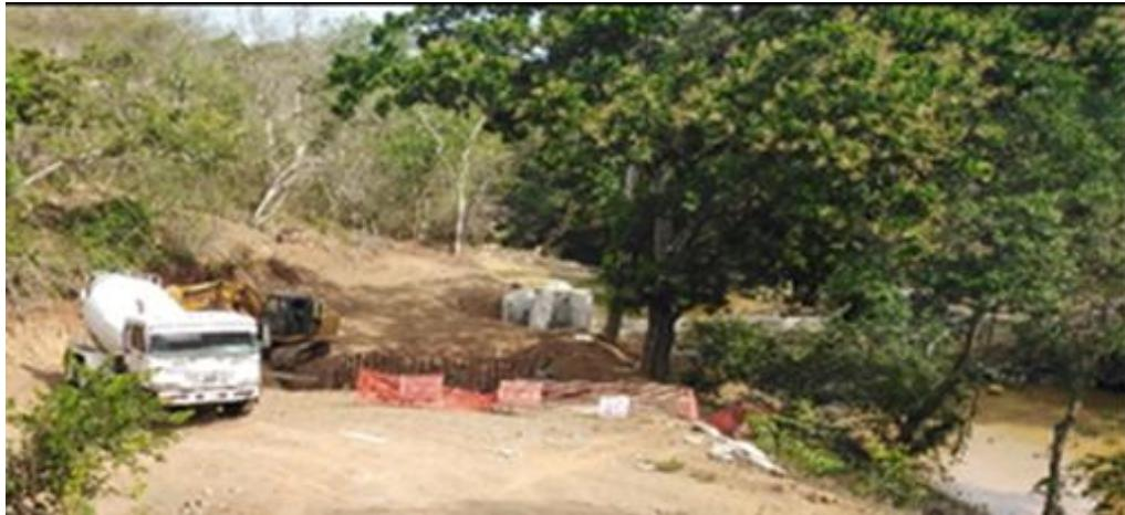
No se mantiene áridos apilados en campo. Se coloca malla de señalización perimetral
