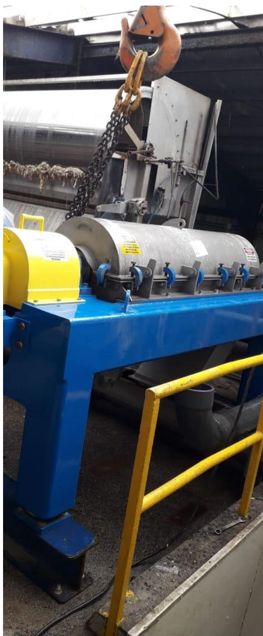
Se realiza la instalación de la nueva centrifuga para deshidratación de lodos
