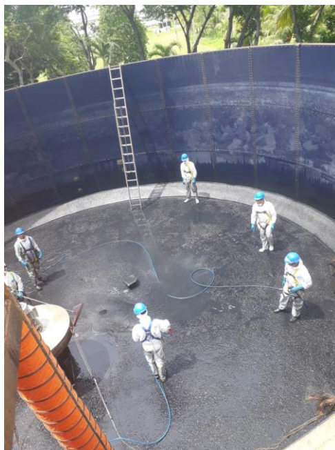
Realización de la limpieza del tanque de homogenización
