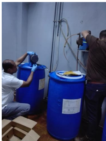
Se instala una nueva bomba dosificadora de coagulante
