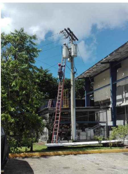
Mantenimiento a transformadores de P.T.A.R.
