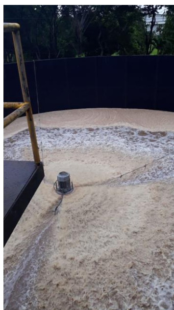
Instalación y mantenimiento del motor aireador del tanque de homogenización
