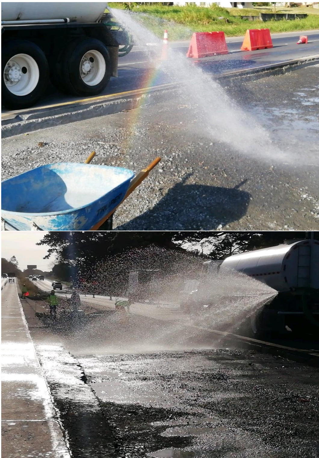
Fotografía 17-18. Control de polvo, para eliminar y/o reducir la emisión de partículas suspendidas en la zona de trabajo.
