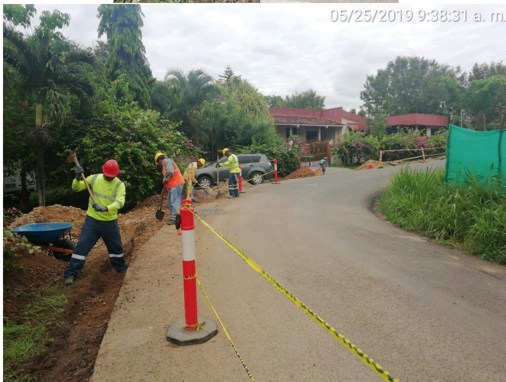
Fotografía 15-16. Canales temporales construidos para transportar los flujos alrededor del área de construcción mientras se construyen las obras permanentes de drenaje.
