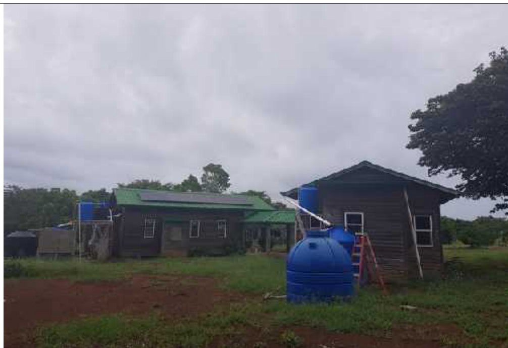
Foto No.3. Dormitorios temporales, con sistema de captación de agua de lluvia y paneles solares.
