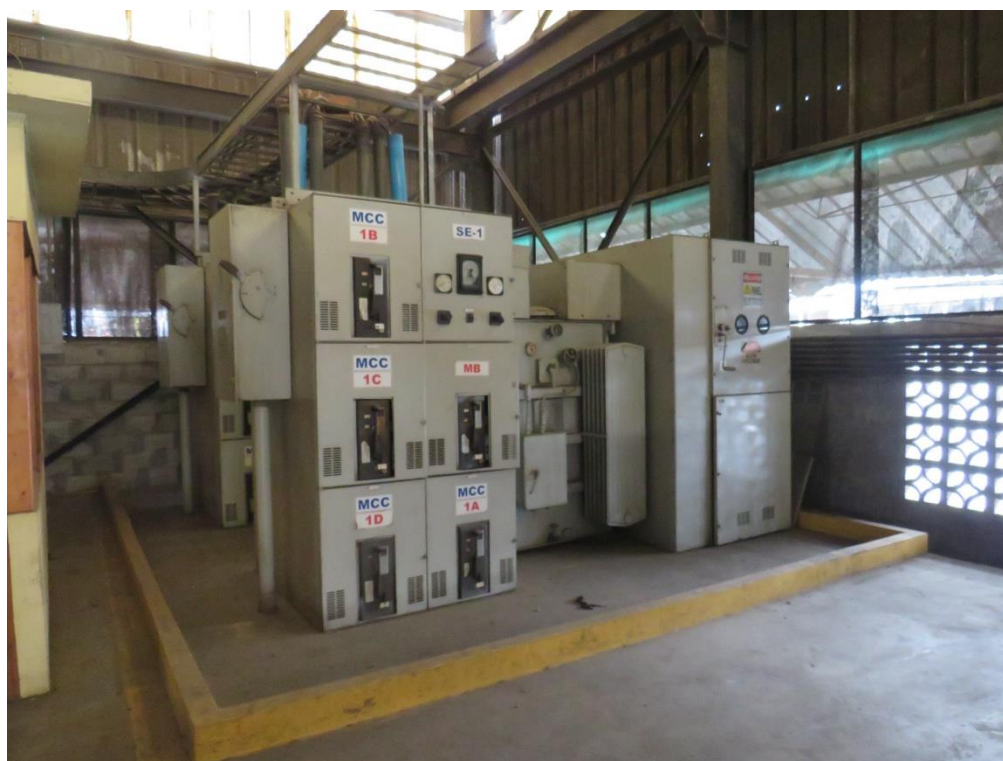
Fotografía 4. Tinas de contención en los transformadores en operación.
