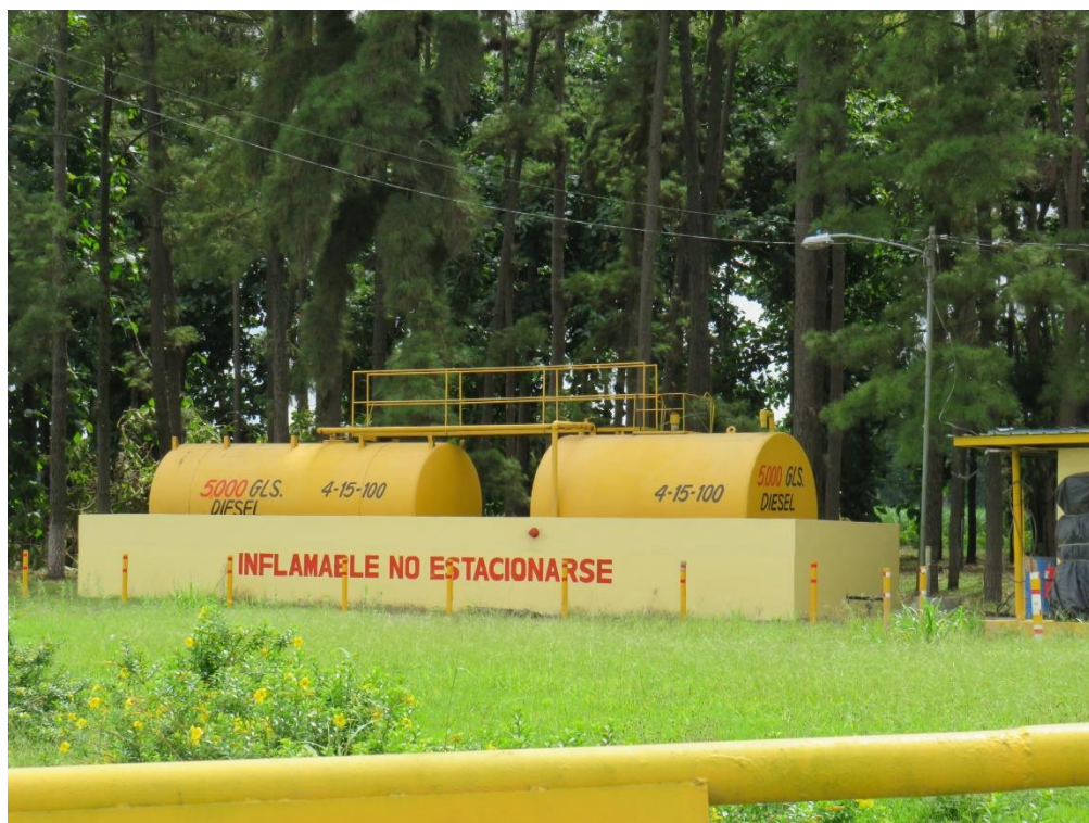
Fotografía 3. Noria de los tanques de combustibles en buen estado
