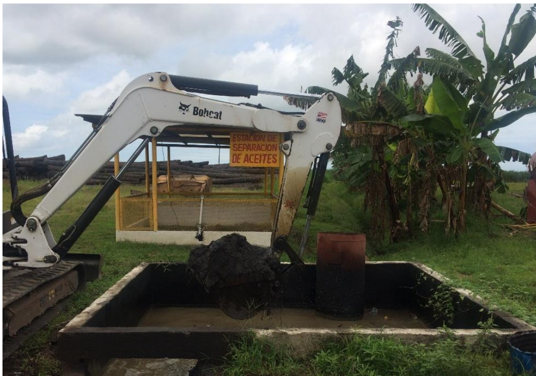
Fotografía 7. Estación de separación de aceites, en el área de taller.
