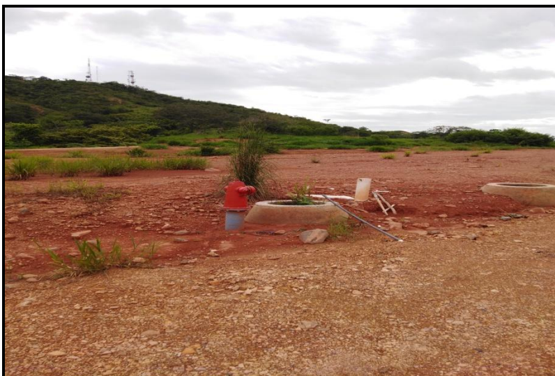
Instalación de tuberías de acueducto y alcantarillado sanitario e hidrantes
