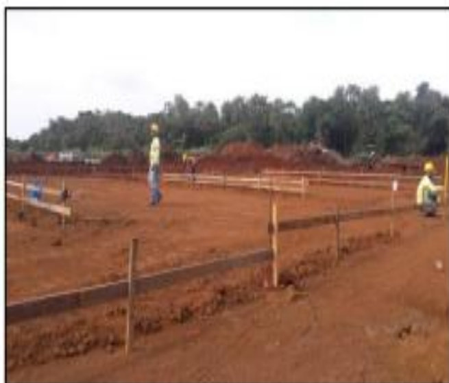
Replanteo de lotes y construcción de pisos y plomería
