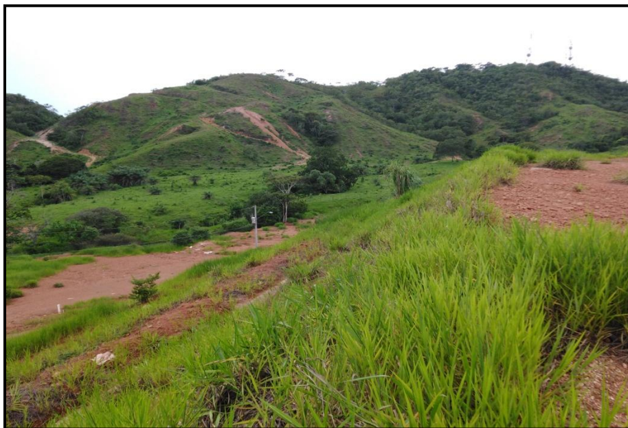
Revegetación de taludes con gramíneas de rápido crecimiento.
