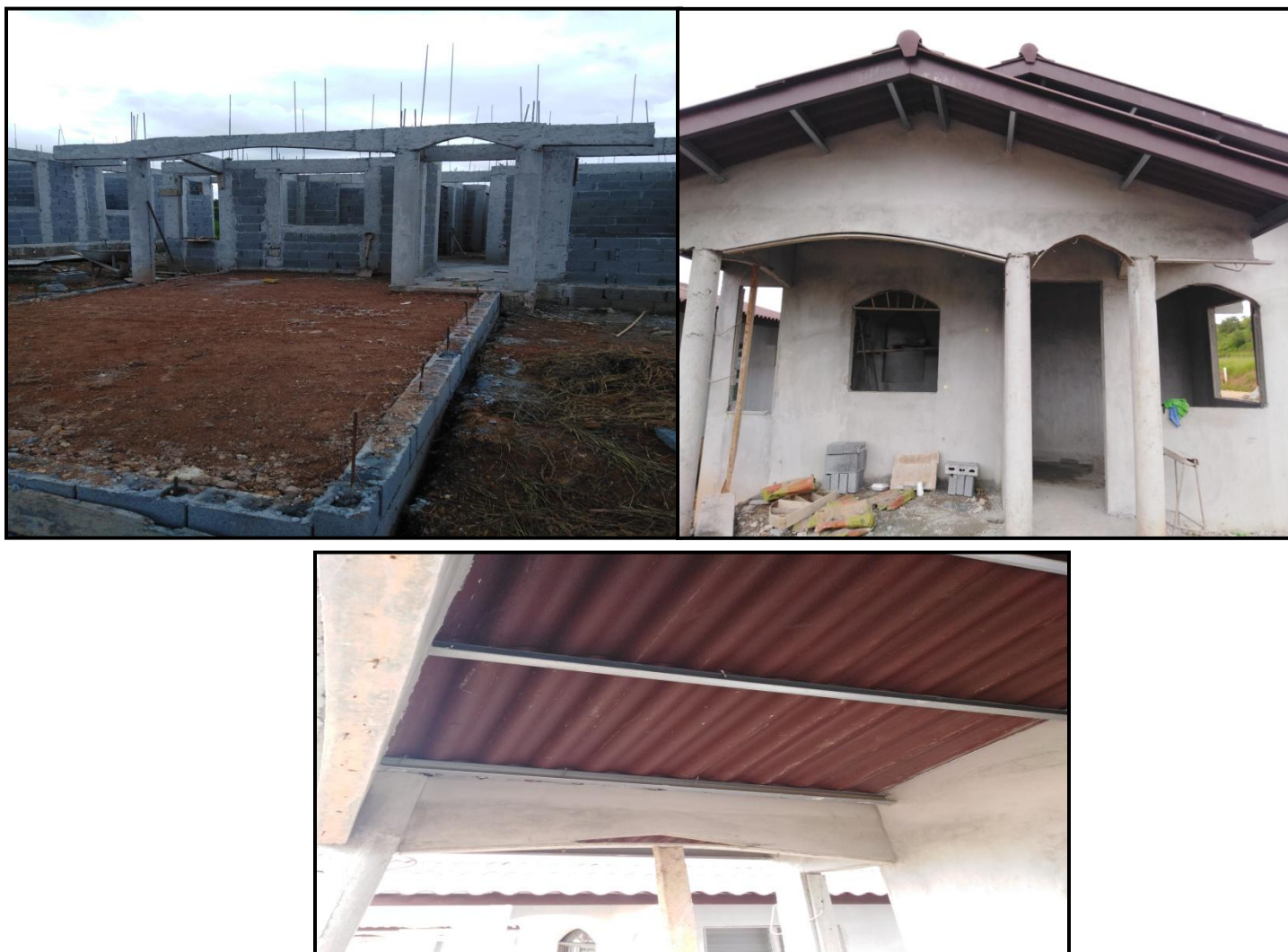
Fundaciones para pisos y paredes, Instalación de plomería y electricidad, Techos y carriolas.
