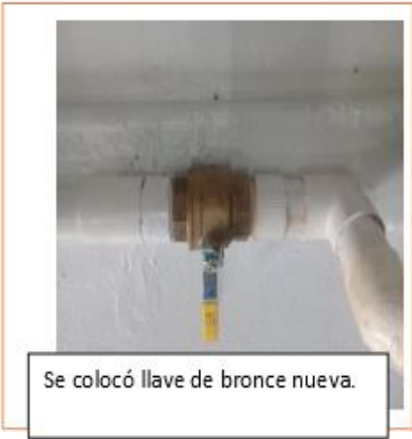
Fuga de Agua en salida de 2 pulgada en el Área de Recibo 16 de Abril 2018
