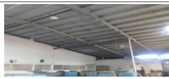
Se instaló 5 Luminarias LED, reemplazando todas las fluorescentes de 400Watt
