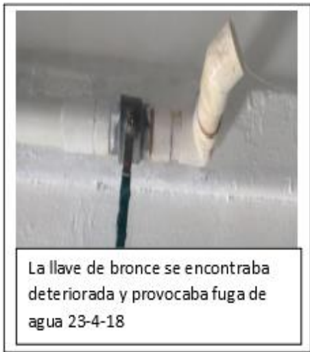
Fuga de Agua en salida de 2 pulgada en el Área de Recibo 16 de Abril 2018
