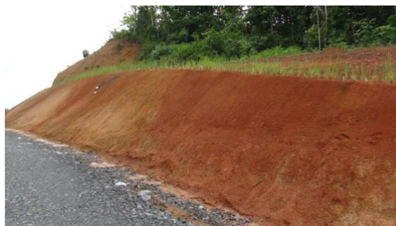
Foto 11) Talud de la vía de acceso que ha sido hidrosembrado y se colocó Betiveria en su cumbre
