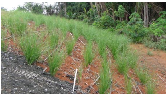
Foto 17) Talud Sureste del redondel sembrado de Betiveria
