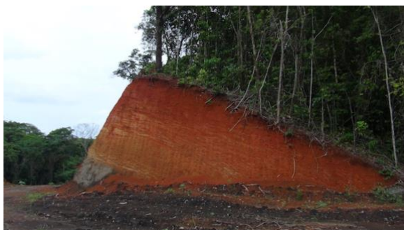
Foto 14) Talud en la intersección de los Lotes 4 y 5 que requiere acciones de control de erosión
