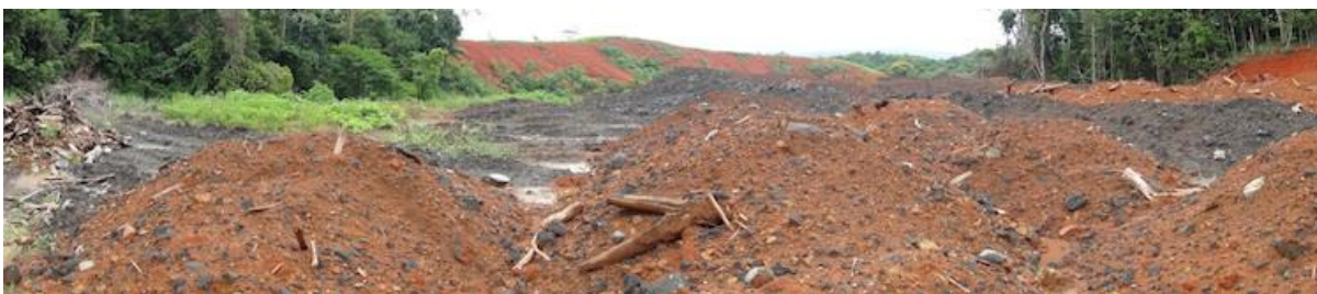
Foto 16) Excedente de excavación depositado en el Lote 11 que requiere de acciones de control de erosión
