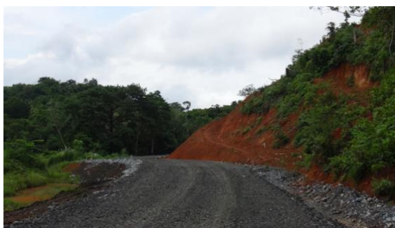
Foto 13) Talud que requiere acciones de control de erosión
