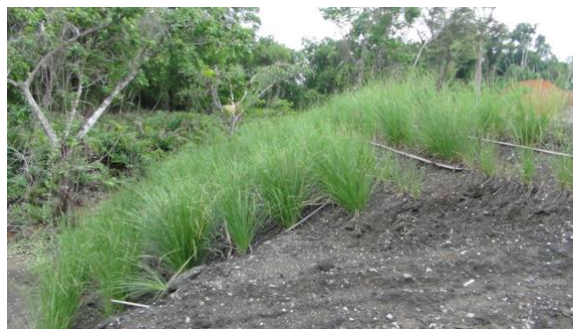
Foto 18) Talud Suroeste del redondel sembrado de Betiveria
