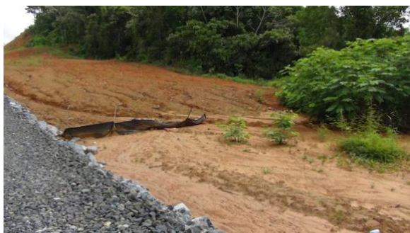
Foto 10) Subida de la vía de acceso luego de la q. Villa Alondra, que requiere acciones de control de erosión
