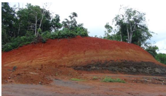
Foto 15) Talud en el Lote 5 que requiere acciones de control de erosión
