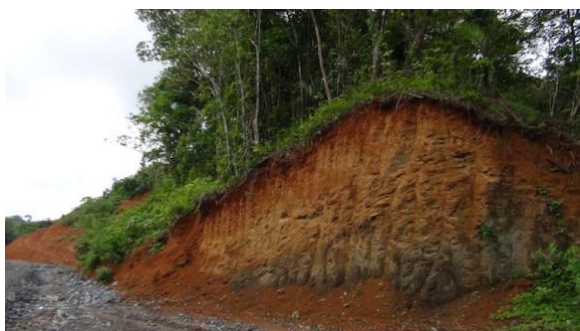
Foto 12) Talud que requiere acciones de control de erosión
