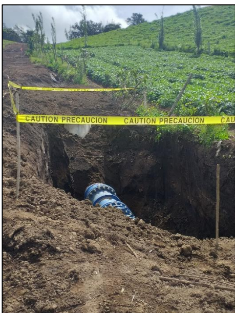
Fotografía N°3-16. Instalación de líneas de conducción
