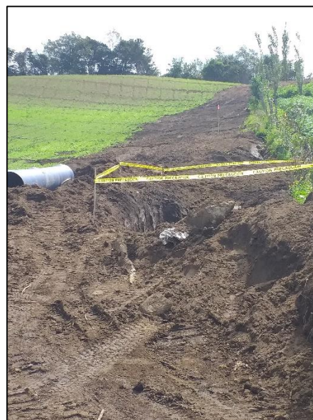
Fotografía N°3-16. Instalación de líneas de conducción
