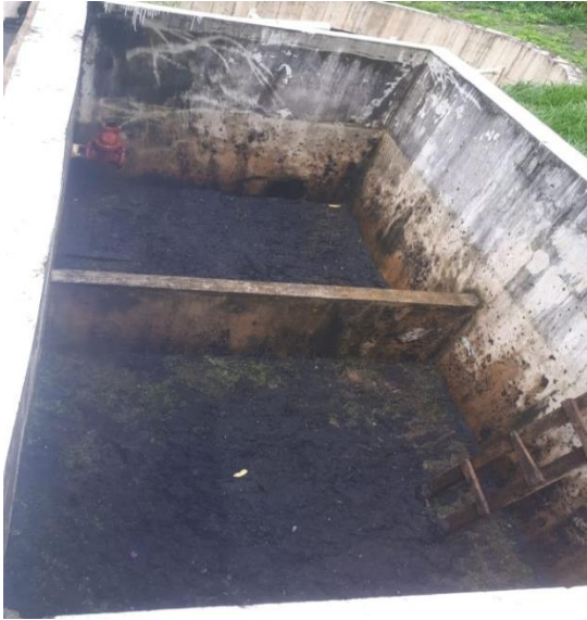
Fotografía No. 11: Tina de secado de lodos provenientes de la PTAR.
