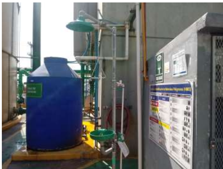
Fotografía No. 6: se observa ducha/lava ojos en el área de la PTAR.
