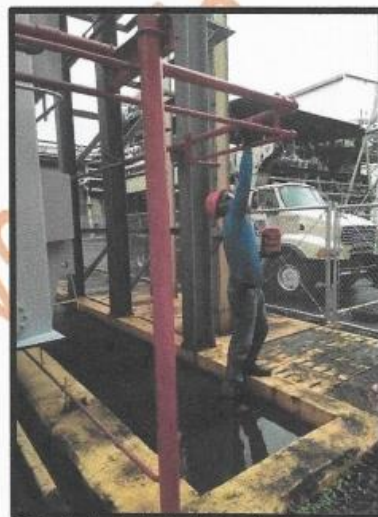
Mantenimiento de pintura de sistema de diluvio
