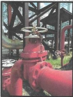
Mantenimiento de valvulas de control
