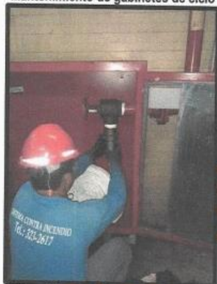
Colocación de manguera de incendio
