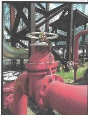
Mantenimiento de valvulas de control
