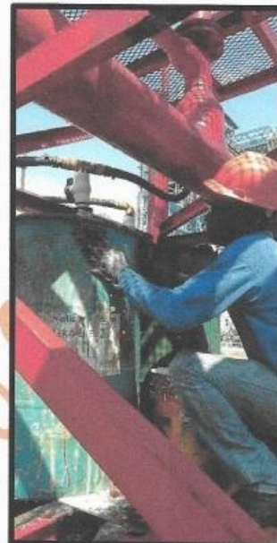
Mantenimiento de de tanques de espuma
