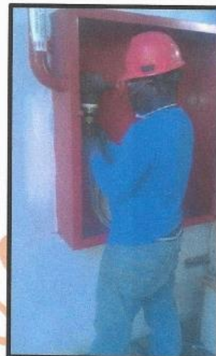
Mantenimiento de valvulas de angulo
