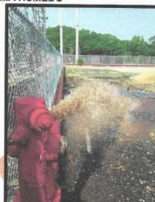
Prueba de flujo en hidrante de SCI
