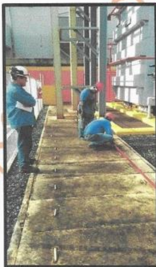
Reparación de línea de aire de piloto del transformador T12
