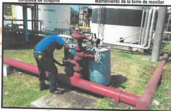
Pintura de tuberías del sistema humedo
