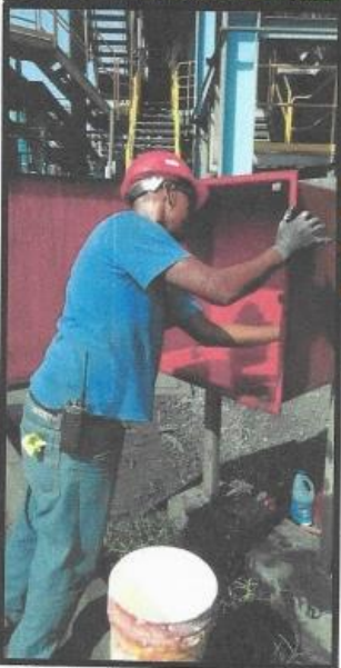
Limpieza de gabinetes de la torre
