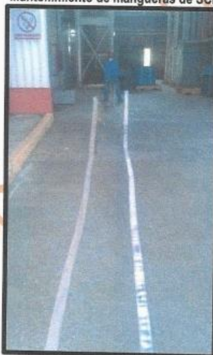
Rotación de mangueras de SCI
