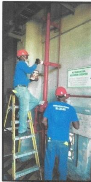
Mantenimiento de tubería de válvula de diluvio
