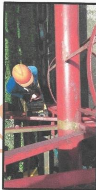
Mantenimiento de la torre de monitor
