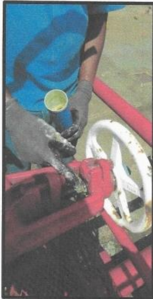
Mantenimiento de valvula de control de monitor
