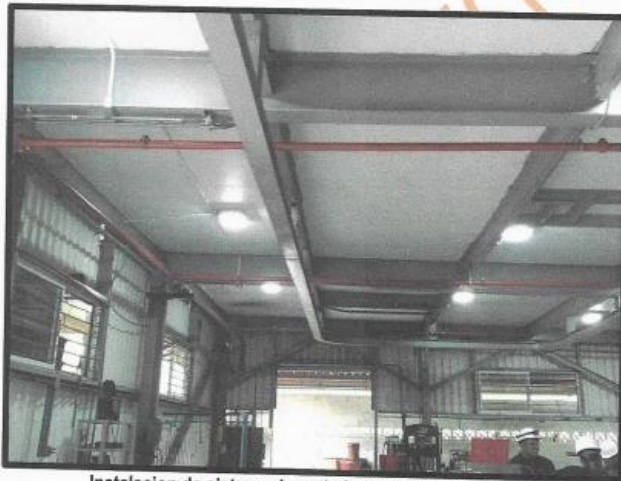
Instalacion de sistema de rociadores en el taller de man
