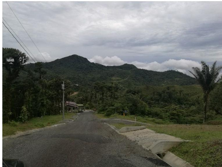
Foto 4. Nótese que las cunetas en las áreas ejecutadas están conformadas, son abiertas y siguen la caída natural del terreno. El terreno se entrega con la rampa de acceso al lote.
