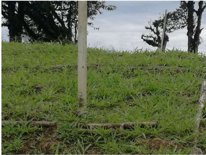
Foto 7. Se utiliza el engramado como medida preventiva para la erosión y sedimentación.
