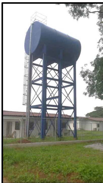
Evidencia Fotográfica N° 10: Tanque de almacenamiento de agua en operación, para los residentes del proyecto. Este Será entregado al IDAAN después de las pruebas respectivas.
