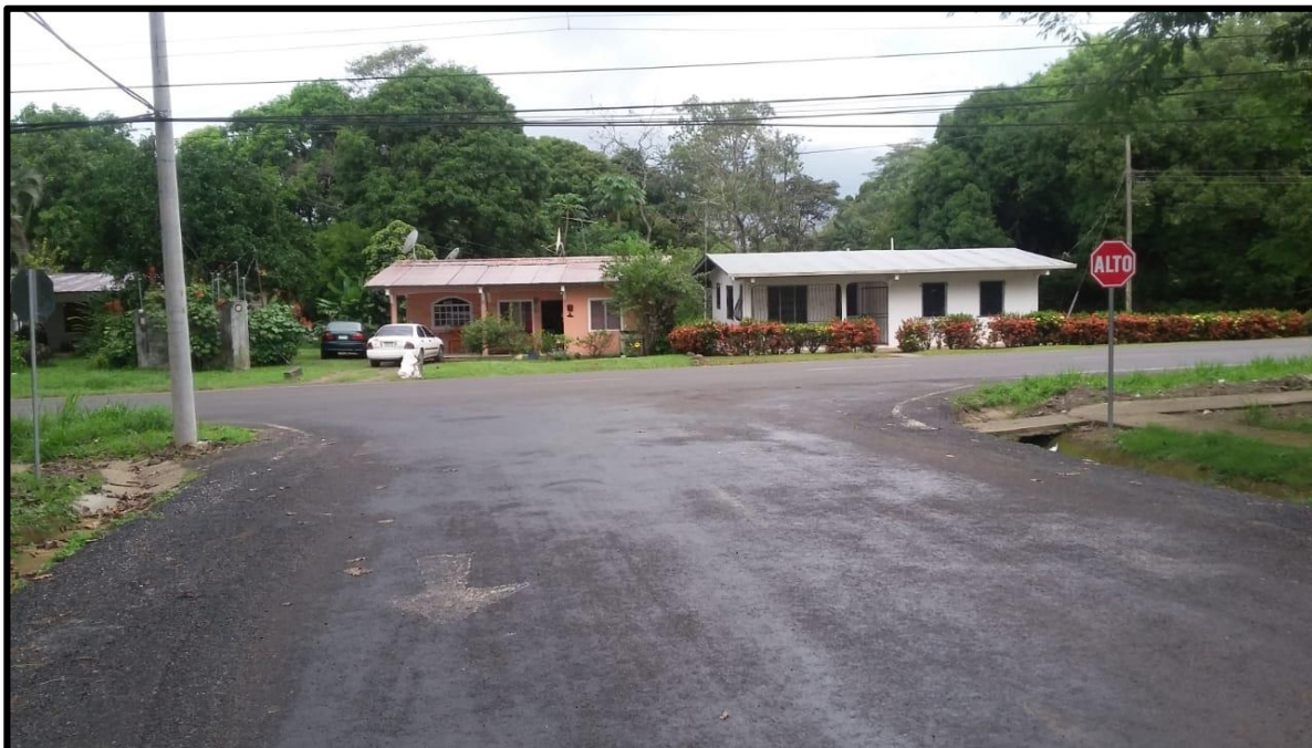
Evidencia Fotográfica N° 5: Calle principal de acceso al proyecto, construida de asfalto y cunetas pavimentadas, terminada.
