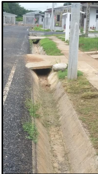
Evidencia Fotográfica N° 4: Construcción de cunetas y aceras Pavimentadas nuevas, según compromisos del PMA. Se observa siembra de grama para protección del suelo.
