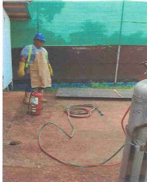
Utilización de Indumentaria de Soldadura para realizar los corte con soldadura oxiacetilénica (oxicorte).
