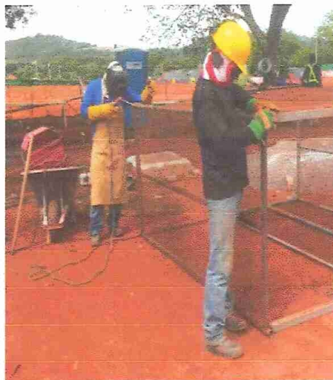
Utilización de Indumentaria de Soldadura para realizar los corte con soldadura oxiacetilénica (oxicorte).
