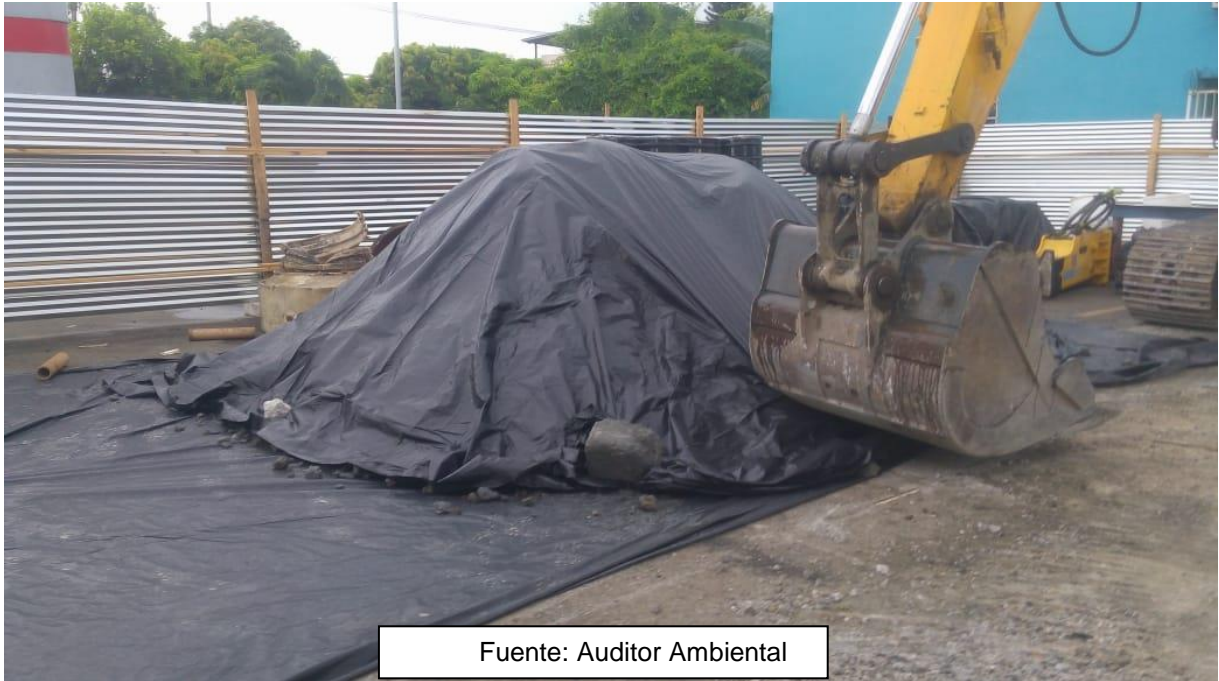
Foto No.3 Protección de material a utilizar con platico negro resistente.
