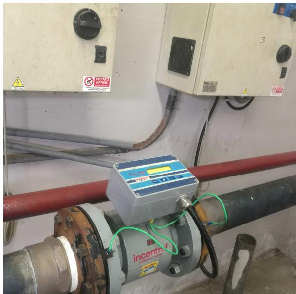
Foto 67. Se han adquirido caudalímetros para monitorear el consumo de agua en los procesos.
