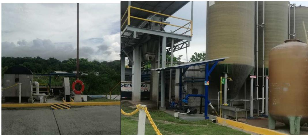
Foto 71-72. Se mejoraron las condiciones de seguridad en la PdTAR, ubicando salvavidas nuevos, una ducha de seguridad con lavaojos.
