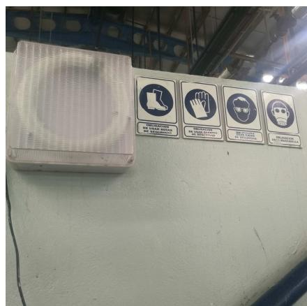
Foto 44. Se mantienen lámparas de emergencia y señalizaciones sobre el EPP necesario en casa operación.
