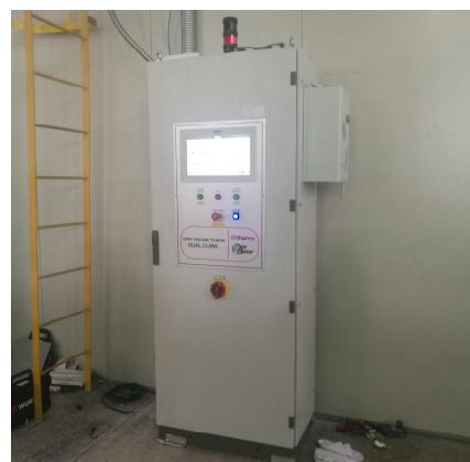
Foto 20. El sistema de secado incorporado esta digitalizado y tiene botón de emergencia.
