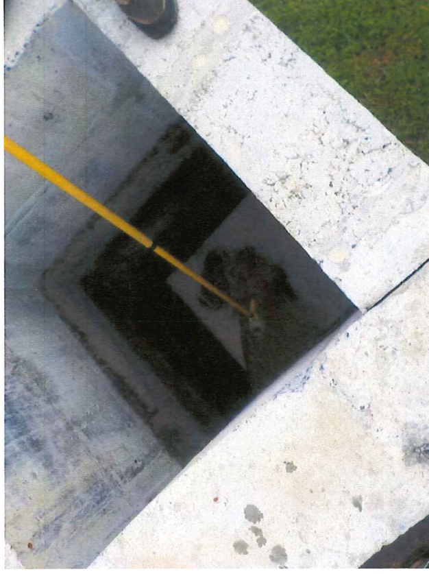
Toma de muestra de agua residual del sedimentador
