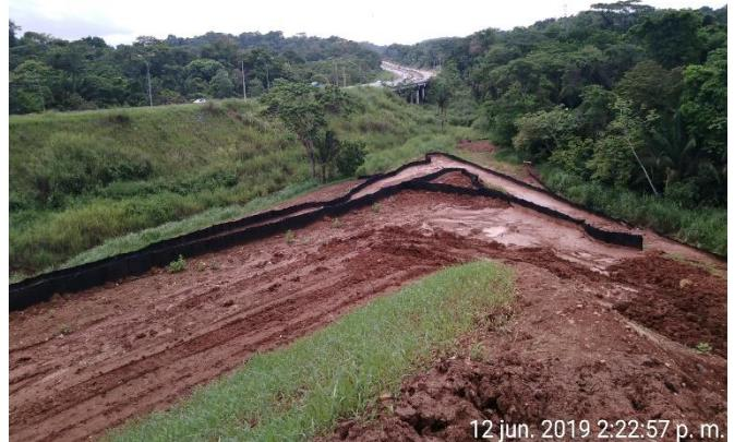
**Evidencias 15-20:** Medidas temporales de control de erosión y sedimentación dentro del proyecto
