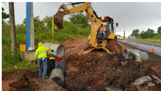
4- instalación de tuberías.
