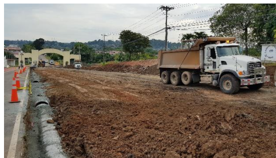
7- volquetes con lona de protección.
