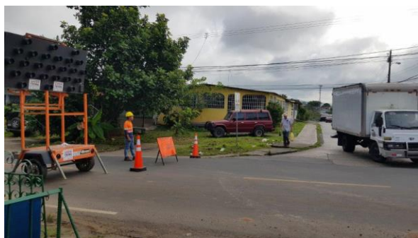
3- Instalación de señalización para control de velocidades y desvios .
