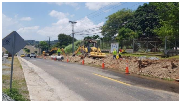
1-Movimiento de tierra y perfilado de carpeta asfáltica.
