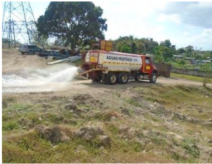
Fotografía 3: Vista general del rociado del paraa para evitar la dispersión de material particulado (polvo)
