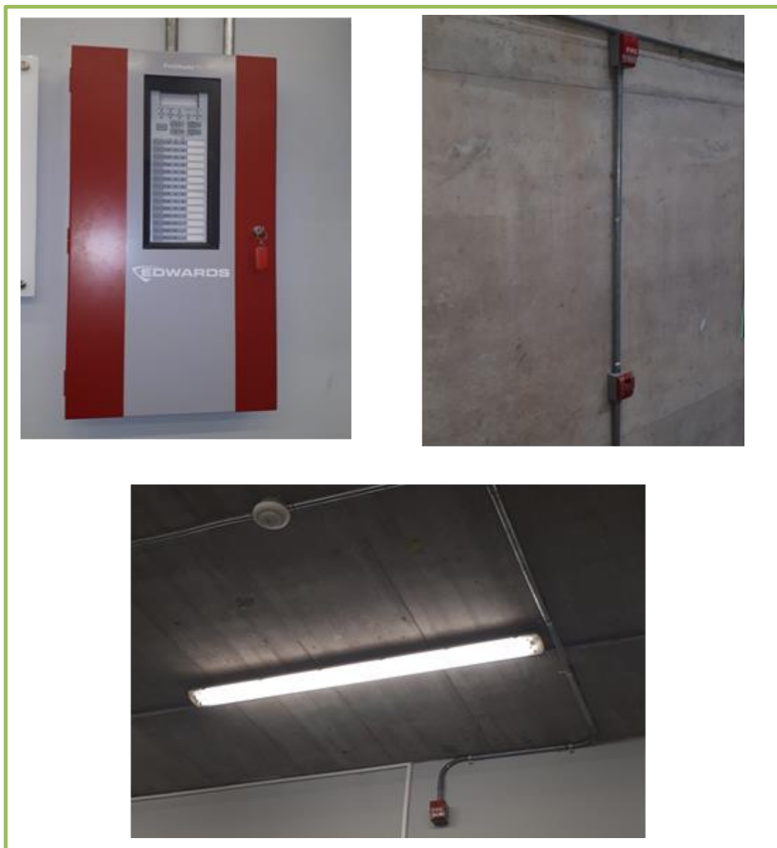
Fig. N°23. Sistema de alarma de detección de incendio.
