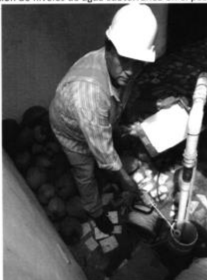
Fig.12 y 13- Instalación del sistema de bombeo, para la posterior aplicación de la prueba de recuperación de niveles de agua subterránea en el pozo PP1.
