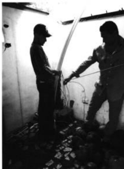
Fig.15- Desinstalación de tubería de bombeo y piezómetro en el pozo PP1
