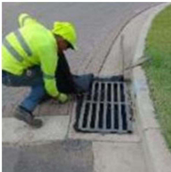
Mantenimiento a malla de contención de sedimentos a nivel de calle
