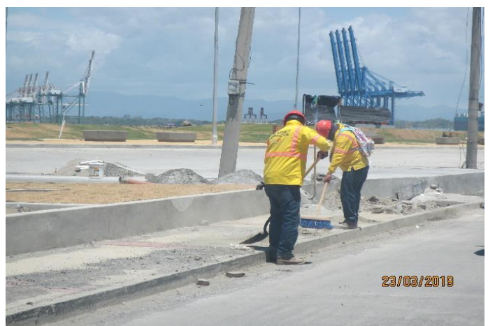
Foto 43-46: Evitar la acumulación de los materiales que impidan el libre flujo de las agua de escorrentía.
