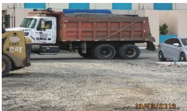
Foto 21-22: Los camiones volquetes utilizan obligatoriamente las lonas, para cubrir el material transportado y evitar o reducir la dispersión de los materiales o incidentes/accidentes que lamentar.
