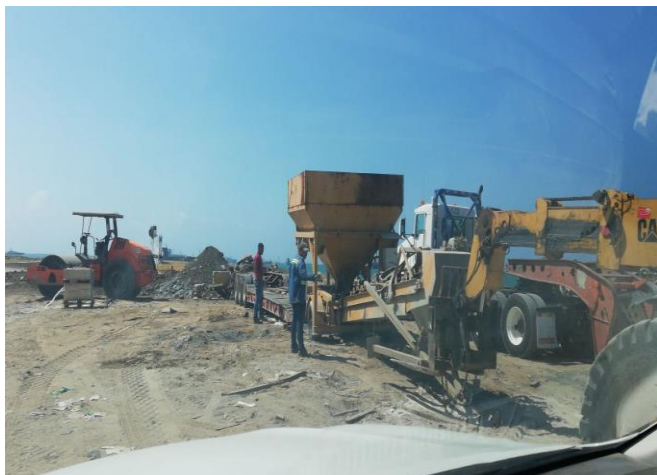
Foto 260: Desinstalación de la Mezcladora de Concreto
