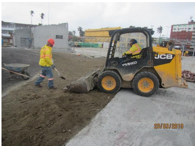
Foto 47-50: Compactación de los suelos expuesto a la erosión y sedimentación en las áreas de trabajo.
