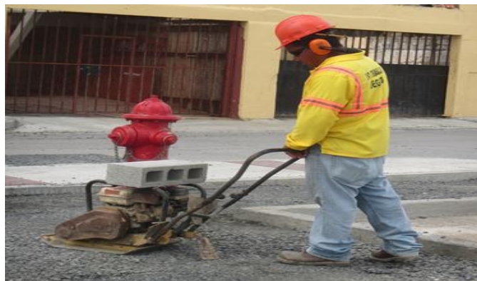
Foto 218-219: Verificar que se entreguen los Equipos de Protección Personal para el control de ruido al personal que lo requieren
