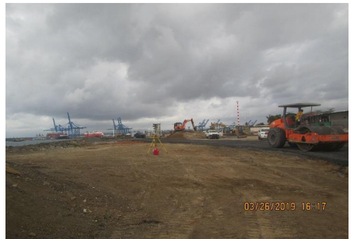
Foto 47-50: Compactación de los suelos expuesto a la erosión y sedimentación en las áreas de trabajo.
