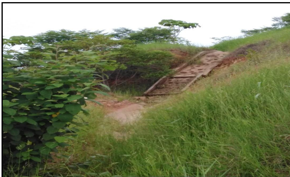
Zampeados de roca y concreto para el drenaje pluvial
