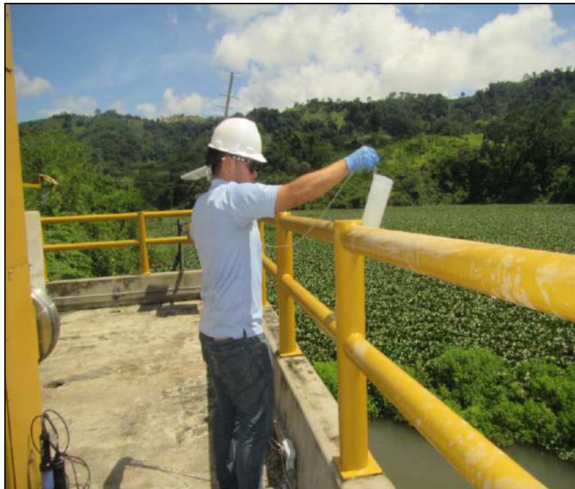
Obra de toma de bajo la mina.
