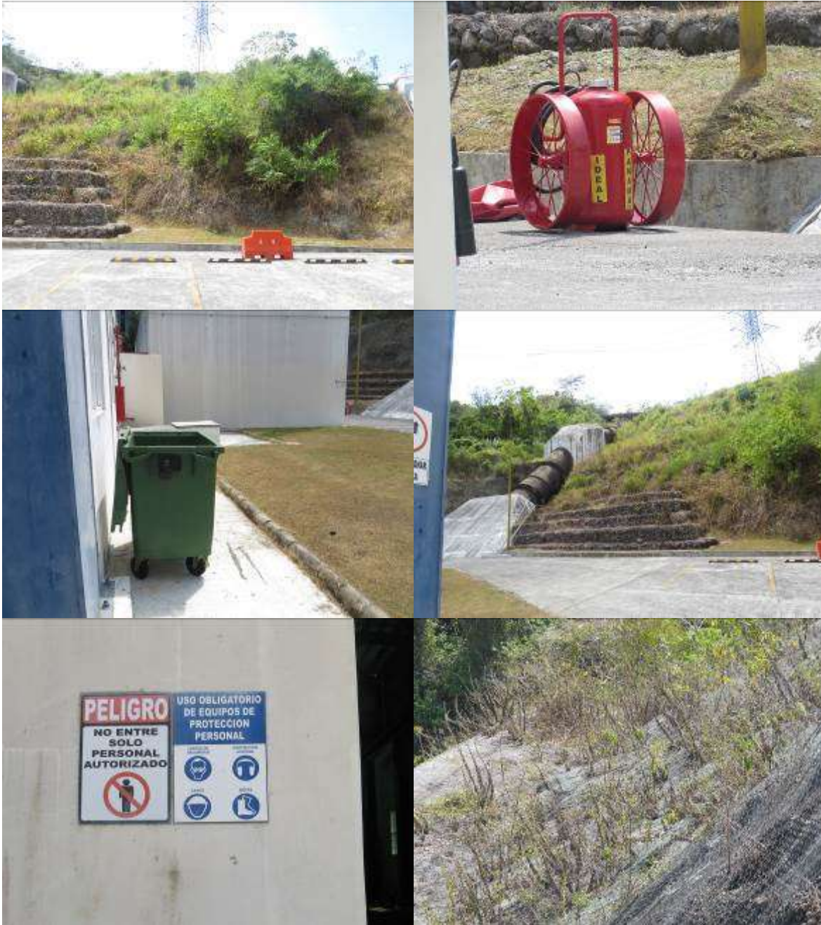
Fotografía 7-12: Revegetación en los diferentes frentes del Proyecto, colocación de Letreros informativos, cestos de recolección de basura, colocación de extintores de mayor capacidad en el proyecto.
