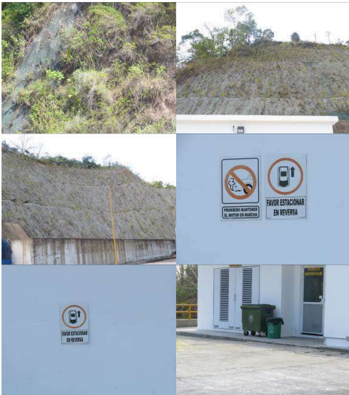
Fotografía 13-18: Revegetación en los diferentes frentes del Proyecto, letreros de como deben estacionarse los vehículos y cestos de recolección de basura en el proyecto.
