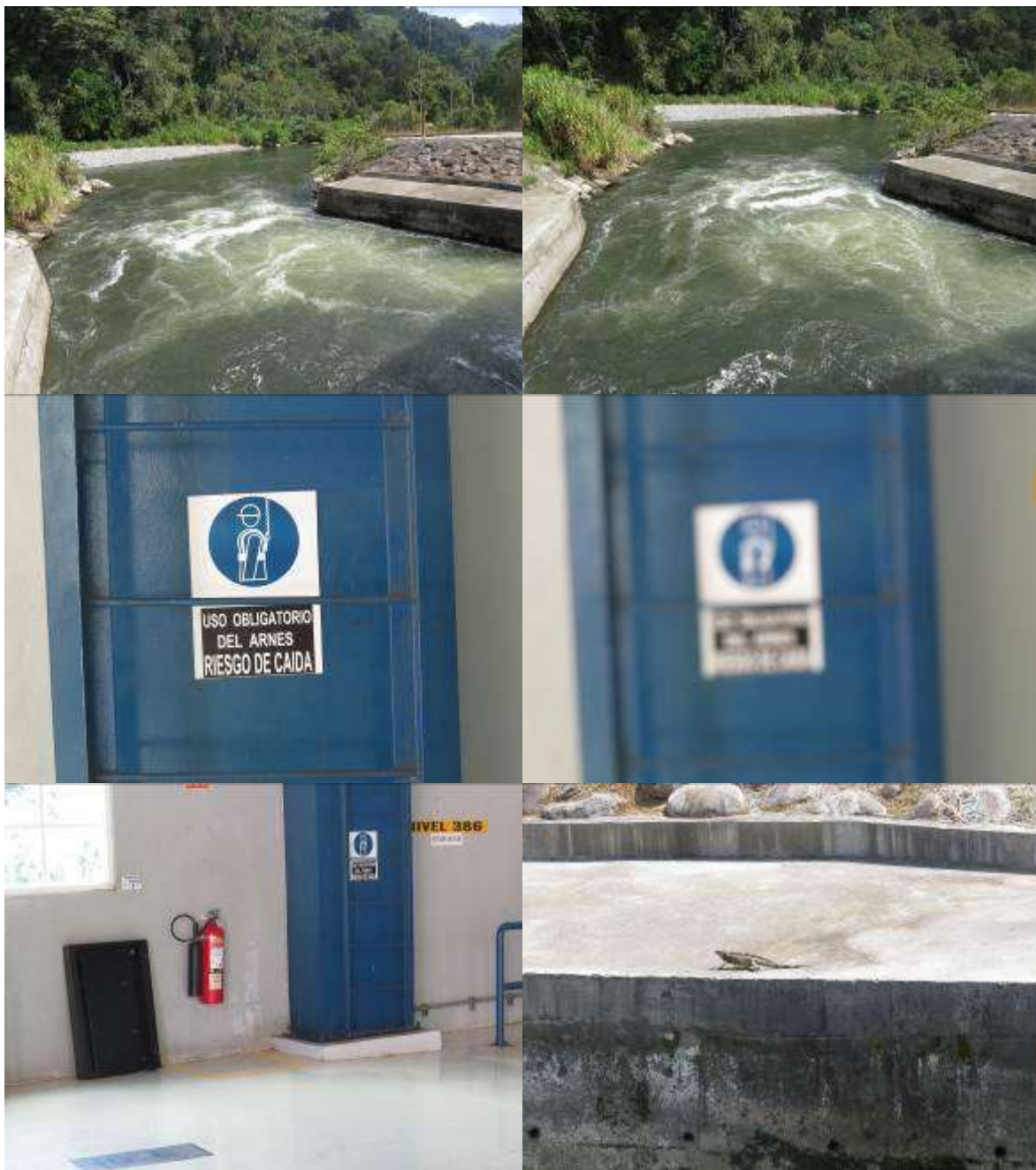
Fotografía 1-6: Salida de la descarga de la casa de maquina de Bajo de Mina, letreros de información al personal que labora en el Proyecto, extintores colocados en Casa de Máquina.
