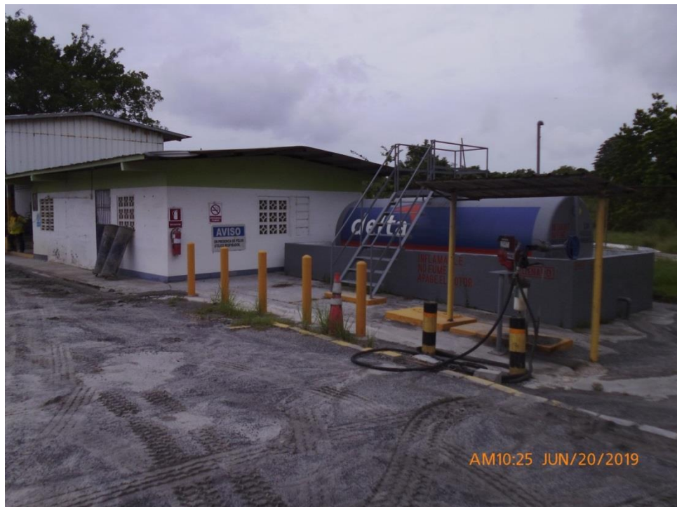
Ilustración 2. Bomba portátil de patio (diésel), existente, con contención secundaria y postes de protección.
