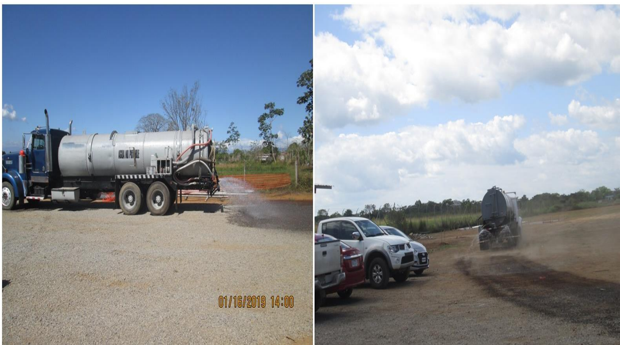
Foto 2. CONTROL DE LEVANTAMIENTO DE POLVO MEDIANTE EL EMPLEO DE RIEGO DE AGUA
