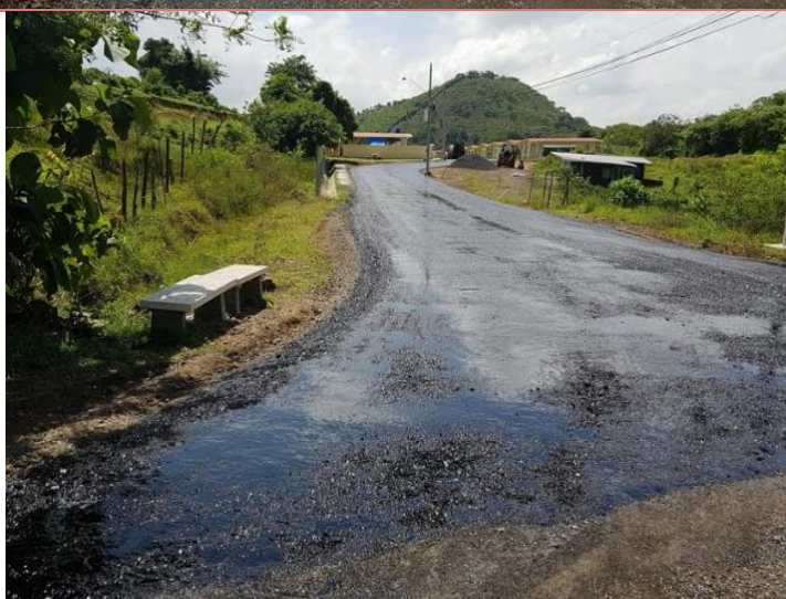
Fotografía N°4. Trabajos realizados en la calle del proyecto (sello asfáltico).
