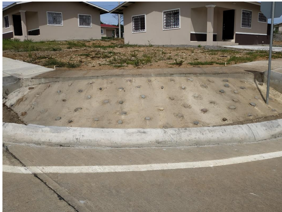
Este zampeado es realizado en diferentes sitios propensos a erosión
