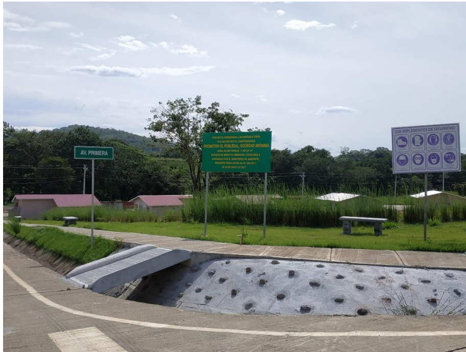
Lugar donde se mantiene el letrero de aprobación del proyecto. Se observa además la medida de control de erosión (zampeado) realizado en área de cuneta.
