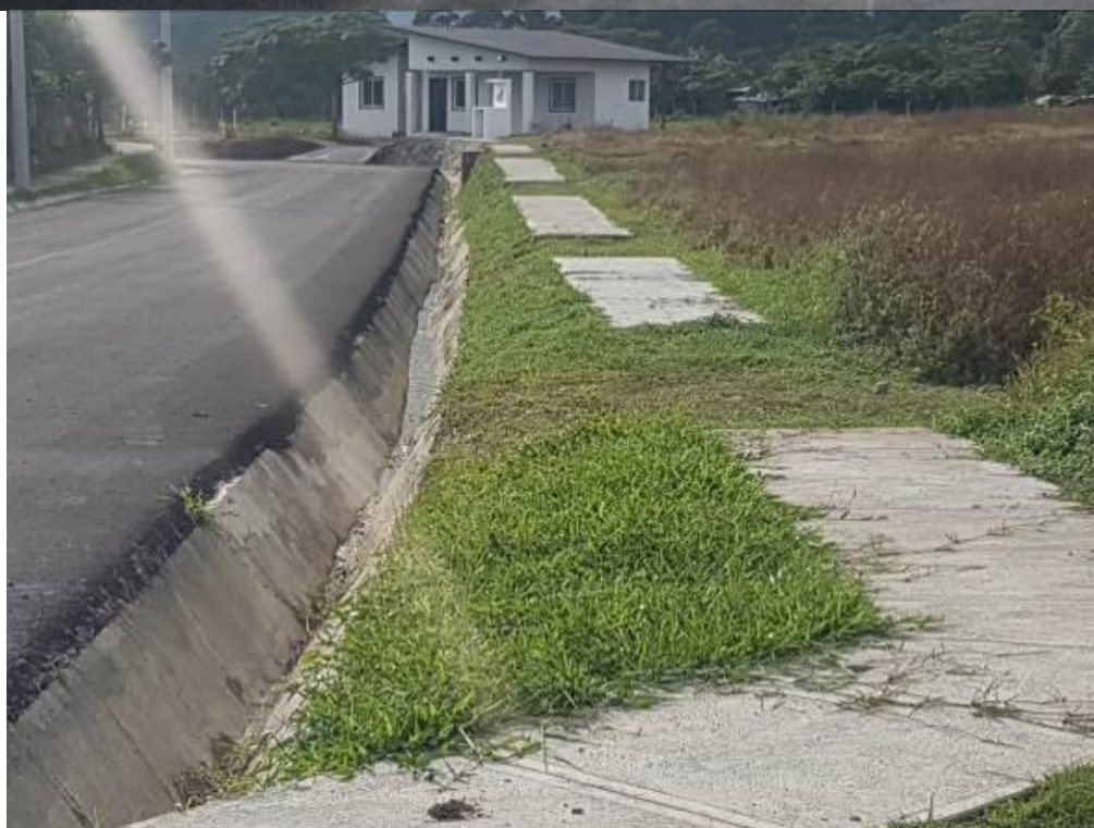
Fotografía 7-8. Cunetas revestidas de concreto y empedrado.
