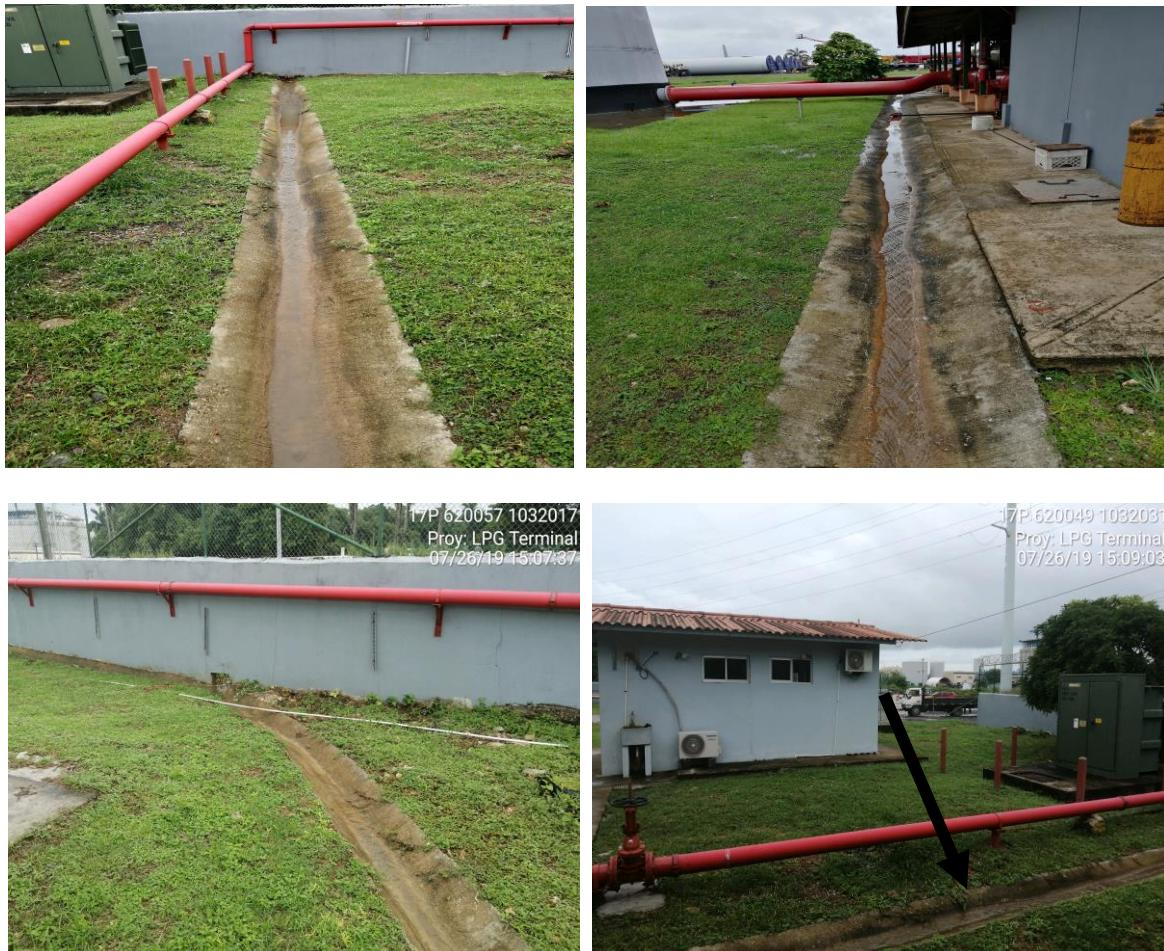
Fotos 1 a 4. Canal pluvial libre de sedimentos y desechos.
